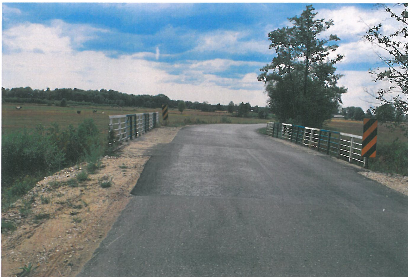
Widok ogólny mostu
