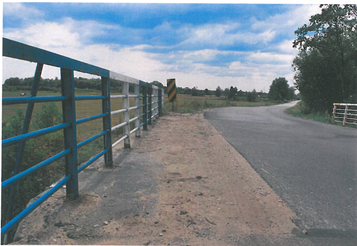
Fot. 7. Zanieczyszczenia, rysy oraz deformacje nawierzchni chodnika.
