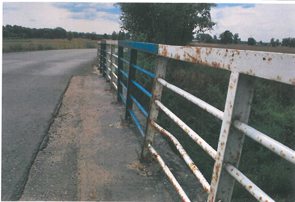
Fot. 8. Zanieczyszczenia, wegetacja roślin, rysy oraz deformacje nawierzchni chodnika.
