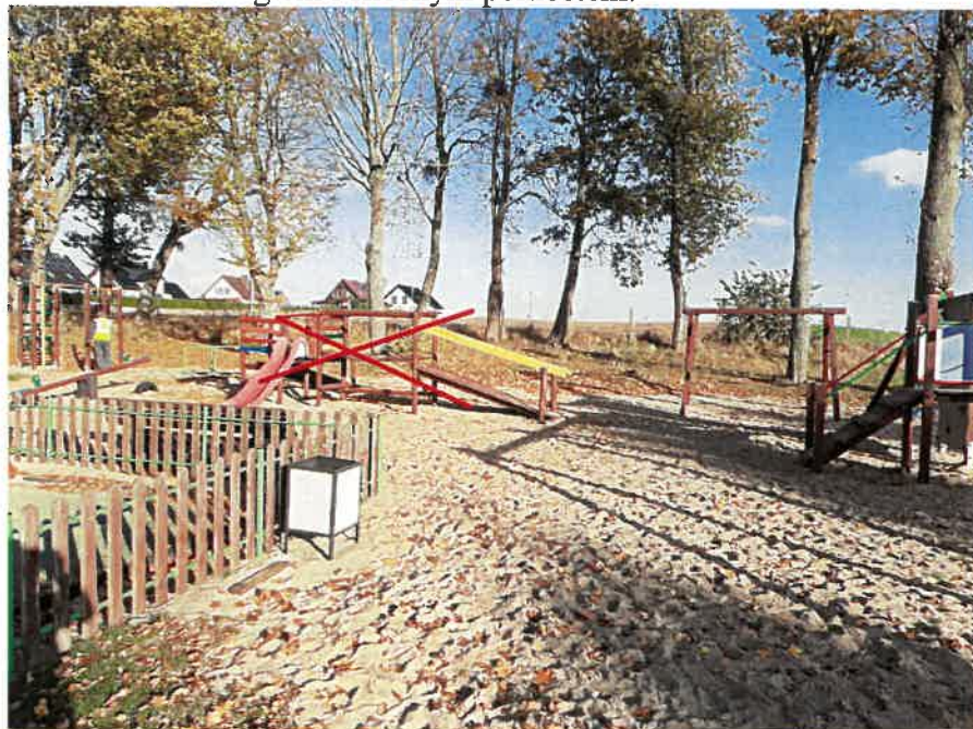
Urządzenie przeznaczone do rozbiórki
