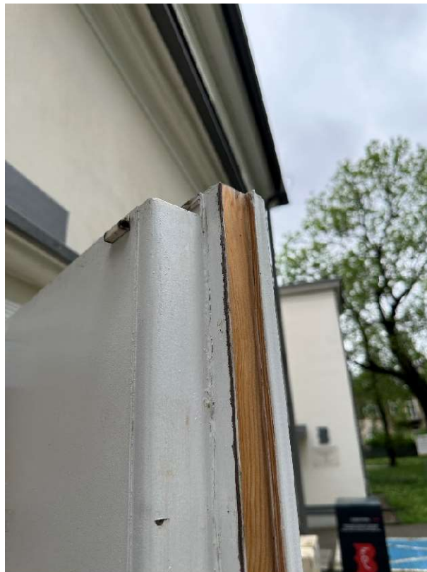
Zdjęcie nr 2. Widoczne stalowe skrzytło z drewnianą okładziną.
