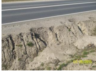
Skarpy, pobocza rozmycia do uzupełnienia
