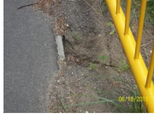
Przepusty - luźne kamienie zabruku do ponownego montażu
