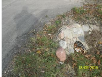
Przepusty - luźne kamienie zabruku do ponownego montażu
