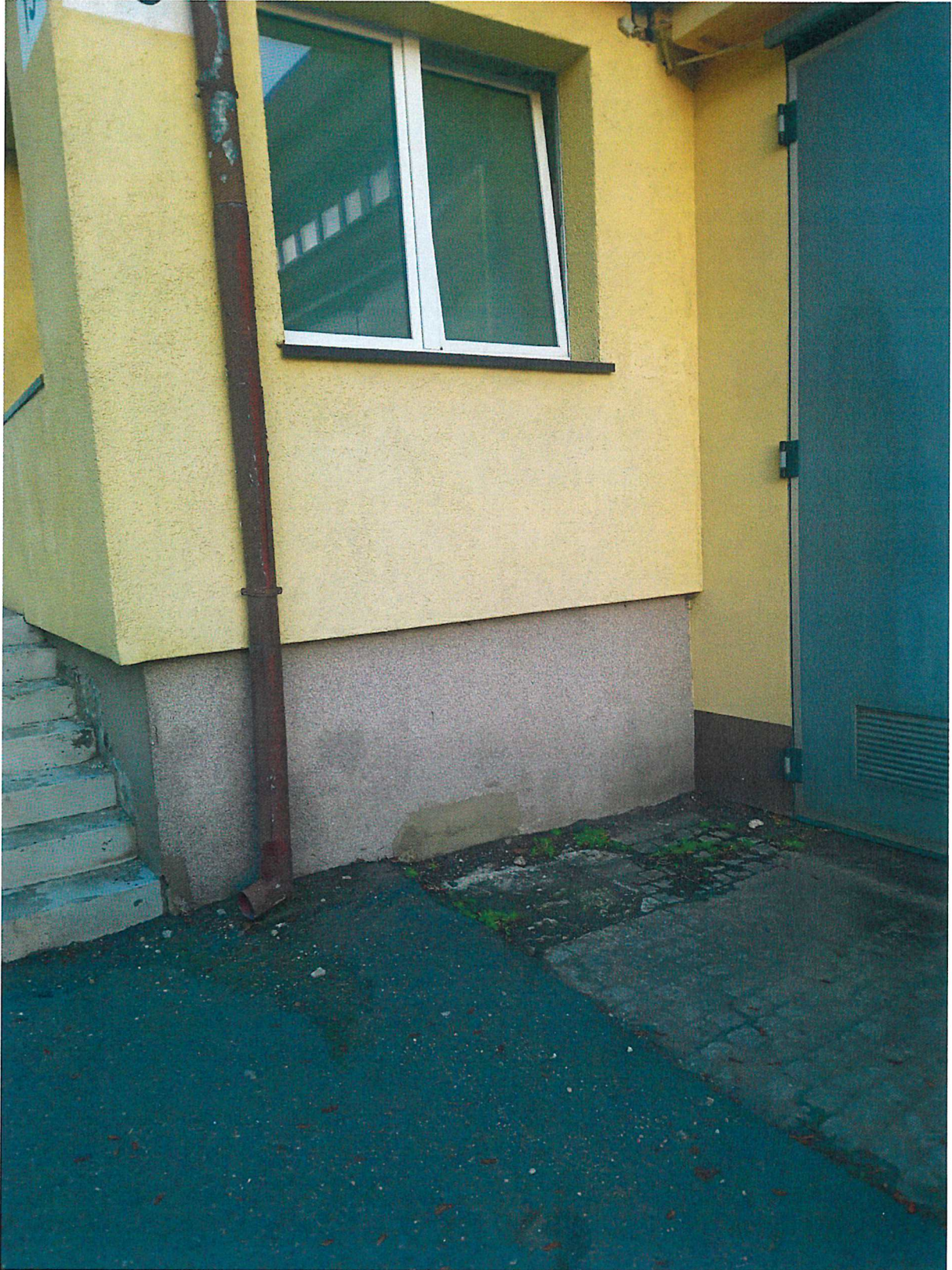
Lokalizacja złącza kablowego ZK-3A – budynek 13
