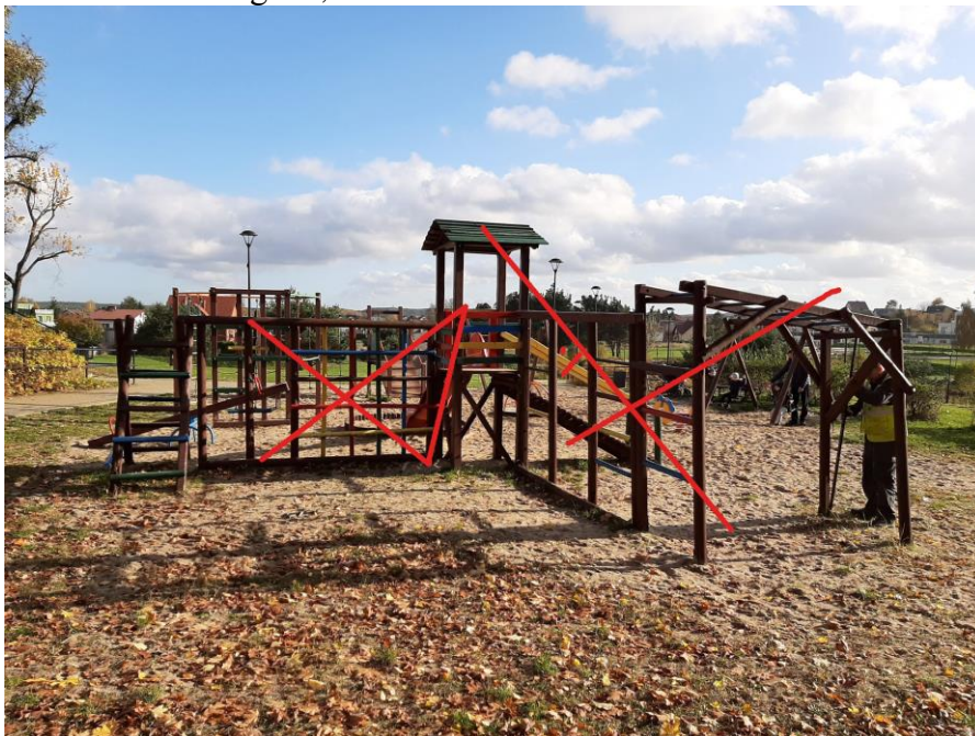
Urządzenie przeznaczone do rozbiórki
