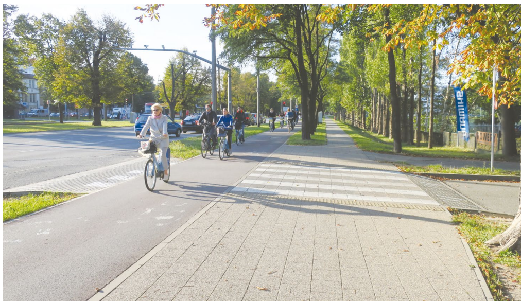
Rycina 55. Poprawne przeprowadzenie drogi dla rowerów przez skrzyżowanie w wariantcie z przebiegiem bezpośrednio przy jezdni ruchu ogólnego; przejście dla pieszych i przejazd dla rowerzystów wyniesione ponad poziom jezdni
