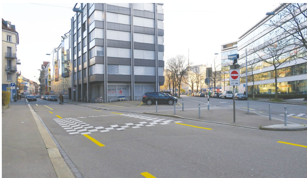
Rycina 19. Droga z uspokojeniem ruchu w postaci progów zwalniających z przepustami dla rowerzystów wzdłuż krawędzi jezdni
