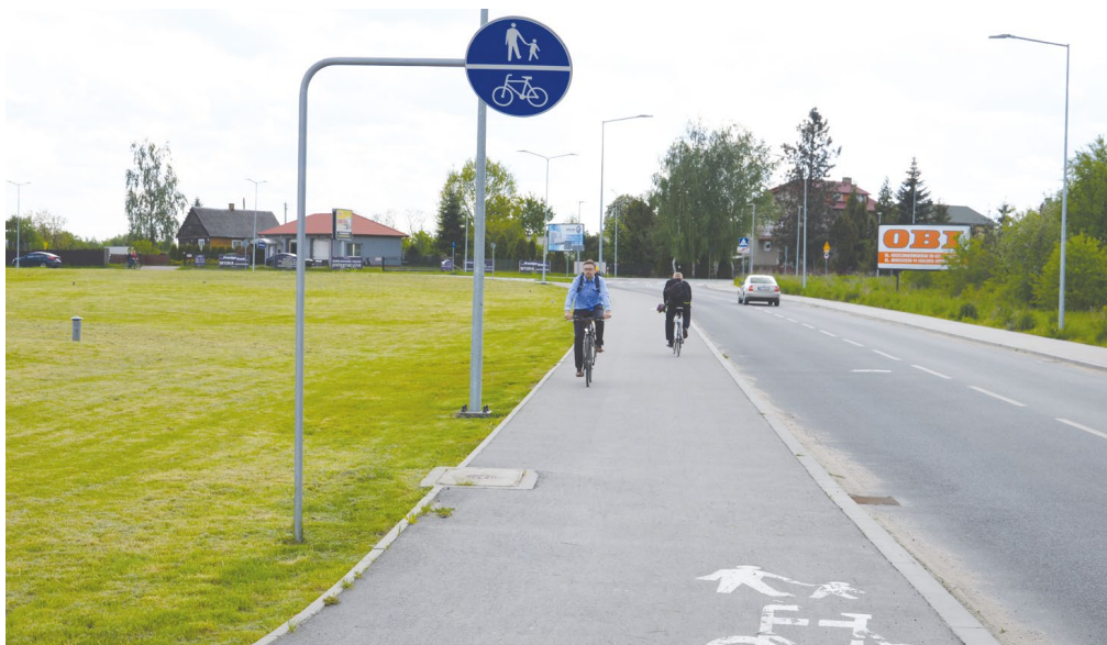
Rycina 15. Przykład prawidłowego zastosowania znaku pionowego na wygiętym wsporniku w celu zachowania skrajni poziomej od strony trawnika. Na zdjęciu widoczny jest jednocześnie nieprawidłowy brak skrajni poziomej od strony jezdni
