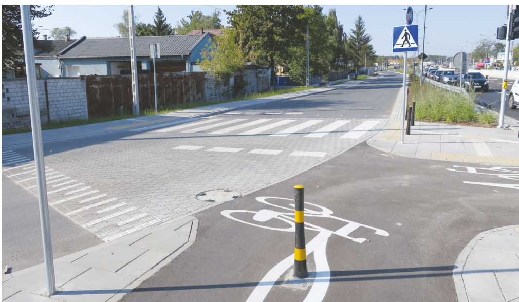
Rycina 42. Włączenie drogi dla rowerów w jezdnię na wyniesionym skrzyżowaniu drogi dla rowerów i jezdni
