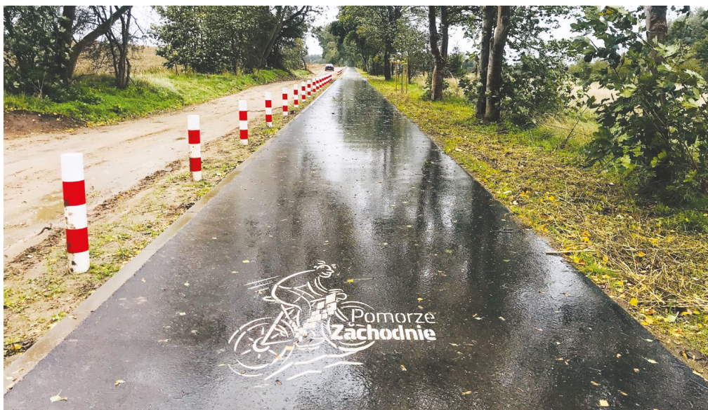
Rycina 30. Zabezpieczenie przed ruchem samochodowym drogi dla rowerów poprowadzonej wzdłuż drogi gruntowej (Fot. Urząd Marszałkowski Województwa Zachodniopomorskiego)
