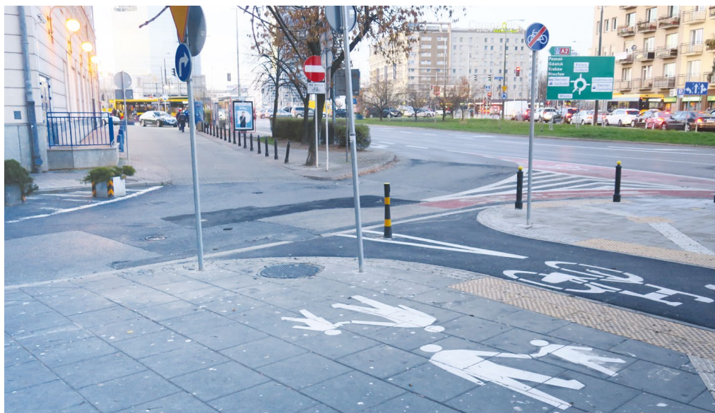
Rycina 10. Trasa rowerowa składająca się z różnych rodzajów infrastruktury: przechodzi z dróg jednokierunkowych z dopuszczonym dwukierunkowym ruchem rowerów (po lewej i w głębi) w wydzieloną drogę dla rowerów; za kadrem po prawej przechodzi w ciąg dalszy pasa ruchu dla rowerów widocznego przy krawędzi jezdni
