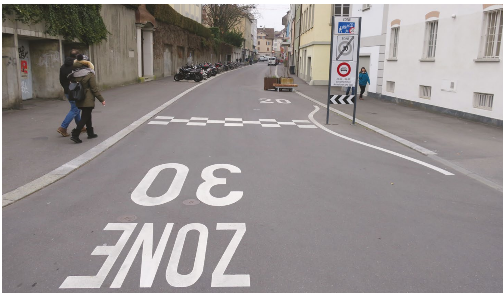
Rycina 17. Przejście ze strefy Tempo 30 do strefy zamieszkania z oznakowaniem i wyposażeniem ulicy w sposób wymagający odgięcia toru jazdy
