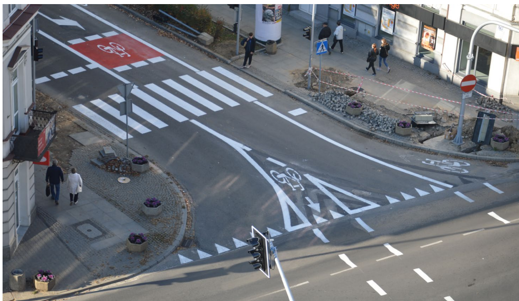
Rycina 27. Śluza ułatwiająca ustawienie się rowerzysty na pasie do lewoskrętu oraz jazdy na wprost przez skrzyżowanie (relacja dostępna tylko dla rowerzystów)
