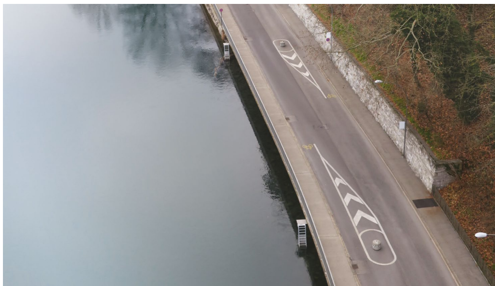
Rycina 18. Droga z uspokojeniem ruchu w postaci esowania toru jazdy z przepustami dla rowerzystów wzdłuż krawędzi jezdni
