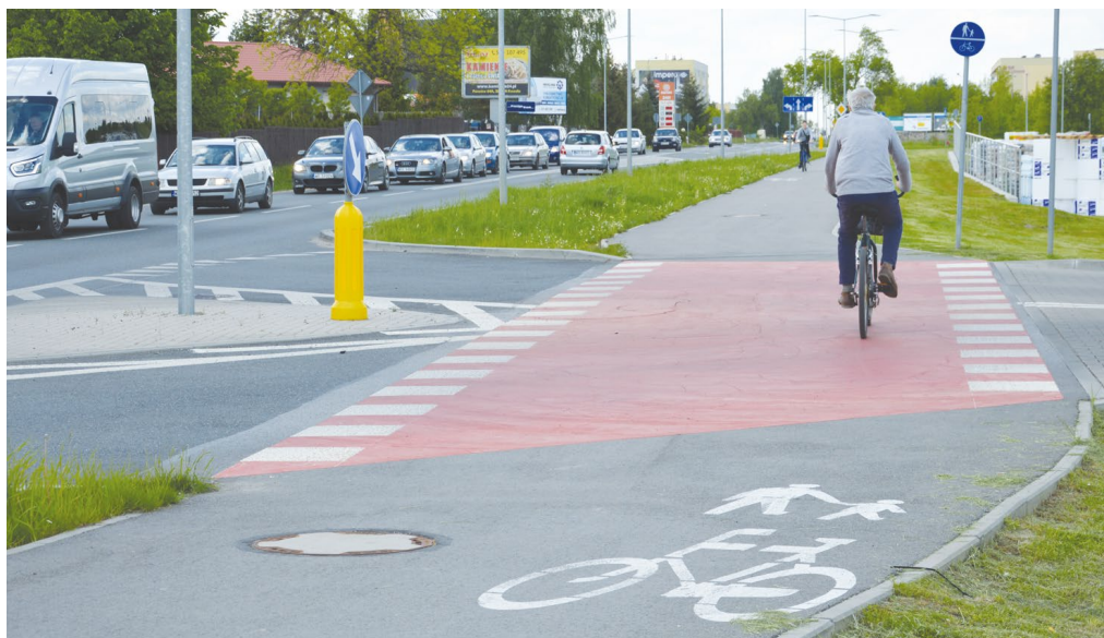
Rycina 51. Przejazd dla rowerzystów w linii ciągu pieszo-rowerowego
