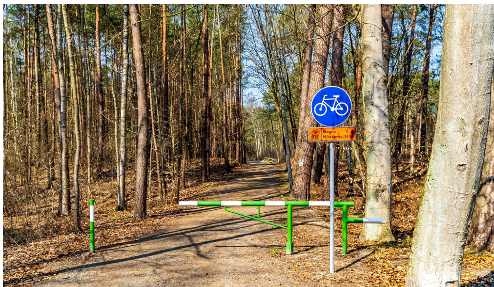
Rycina 62. Zabezpieczenie trasy rowerowej w lesie przed wjazdem pojazdów samochodowych z zachowaniem dostępu dla ruchu rowerowego i pieszego (Fot. Szymon Nitka, www.znajkraj.pl )
