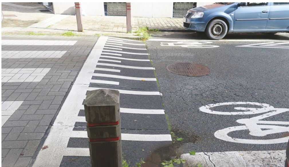
Rycina 24. Przykład progu o przekroju sinusoidalnym
