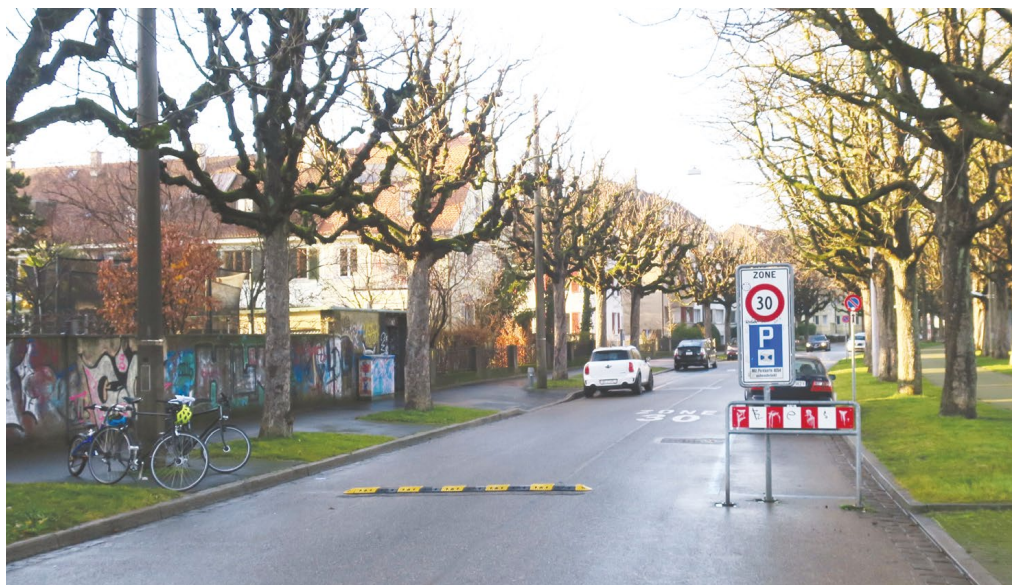
Rycina 26. Organizacja ruchu wymuszająca zwolnienie i esowanie toru jazdy na wjeździe do strefy Tempo 30 z przepustami dla rowerzystów po bokach progu
