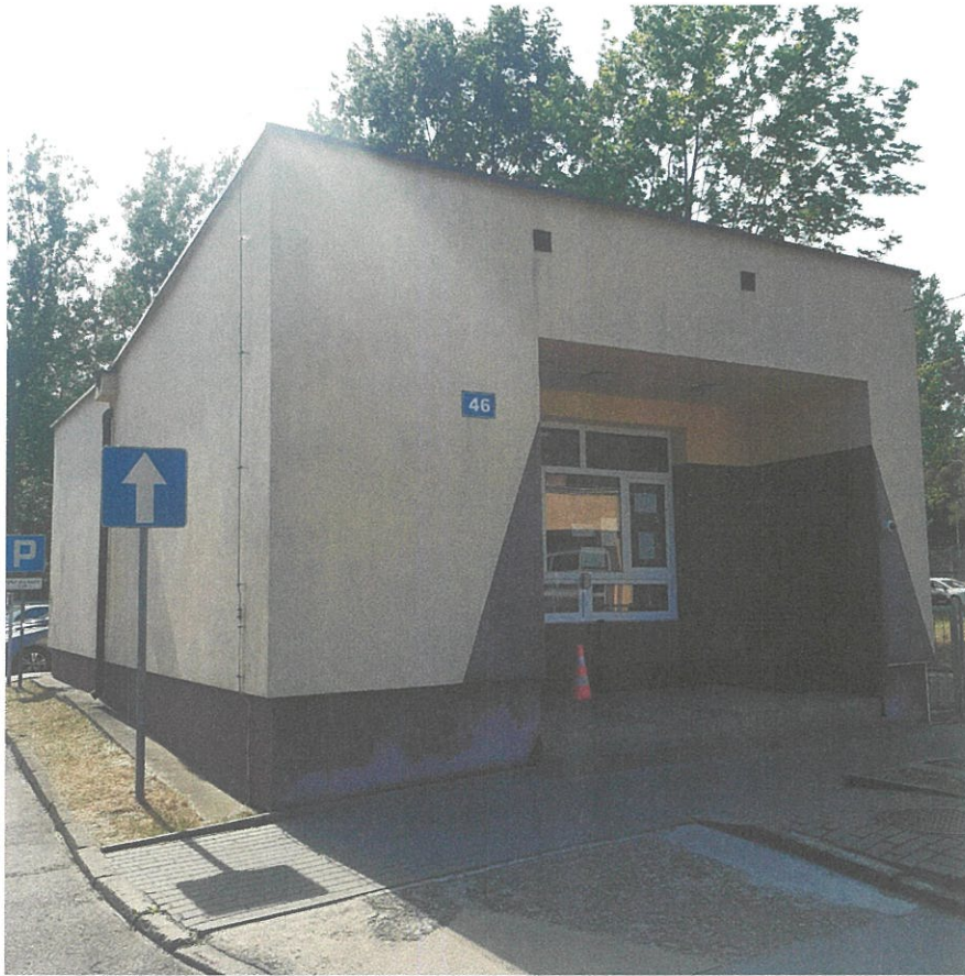
Fot. nr 7 – budynek nr 46
