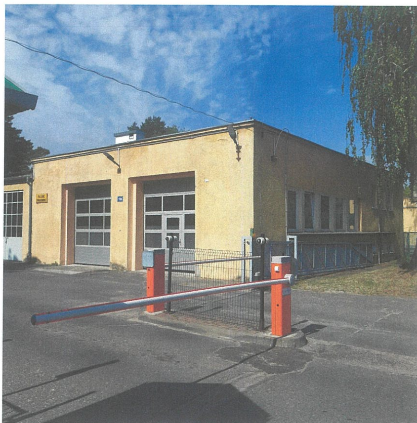
Fot. nr 1 – budynek nr 10
