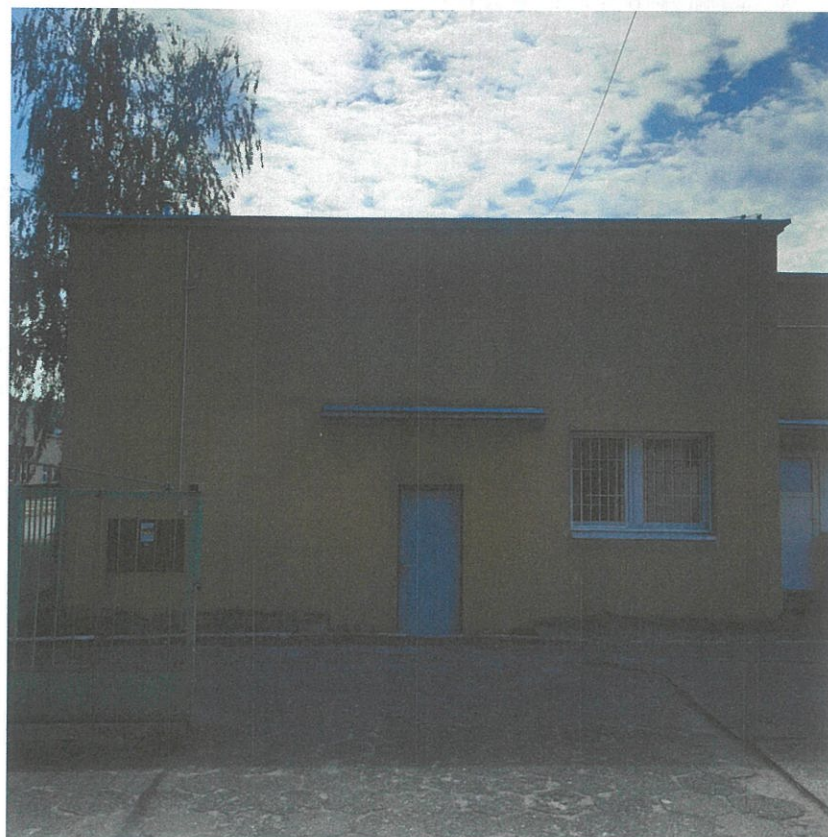
Fot. nr 2 – budynek nr 10
