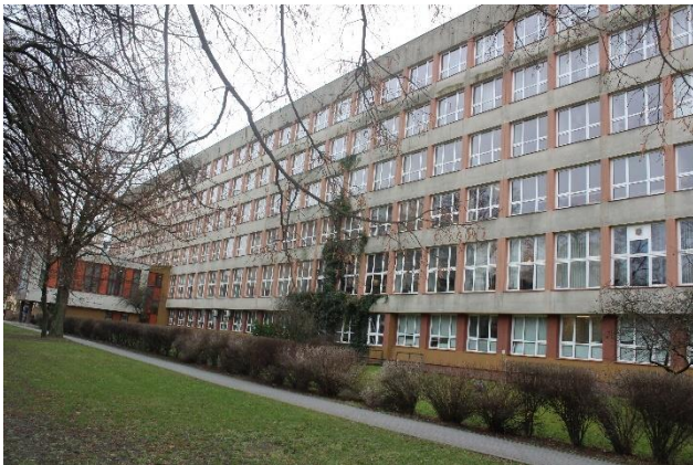
Widok budynku od ul. Nowowiejskiej, zdjęcie z Ekspertyzy technicznej
