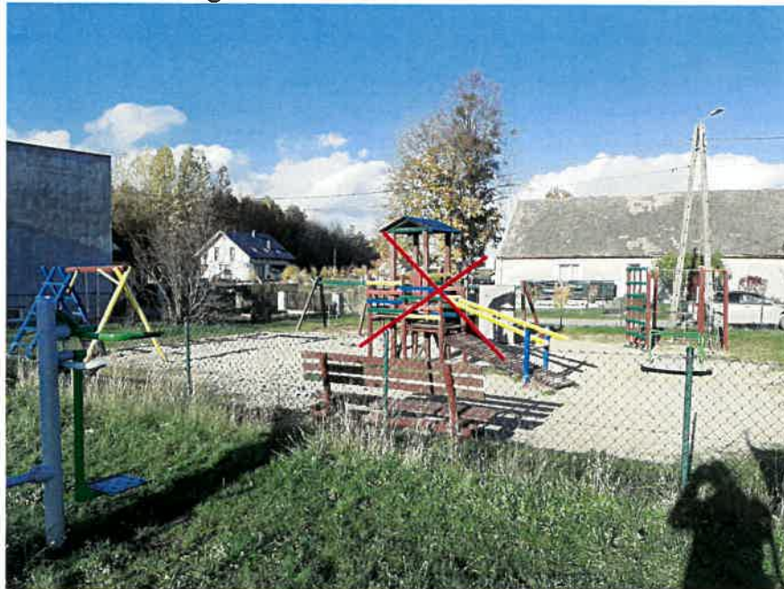
Urządzenie przeznaczone do rozbiórki
