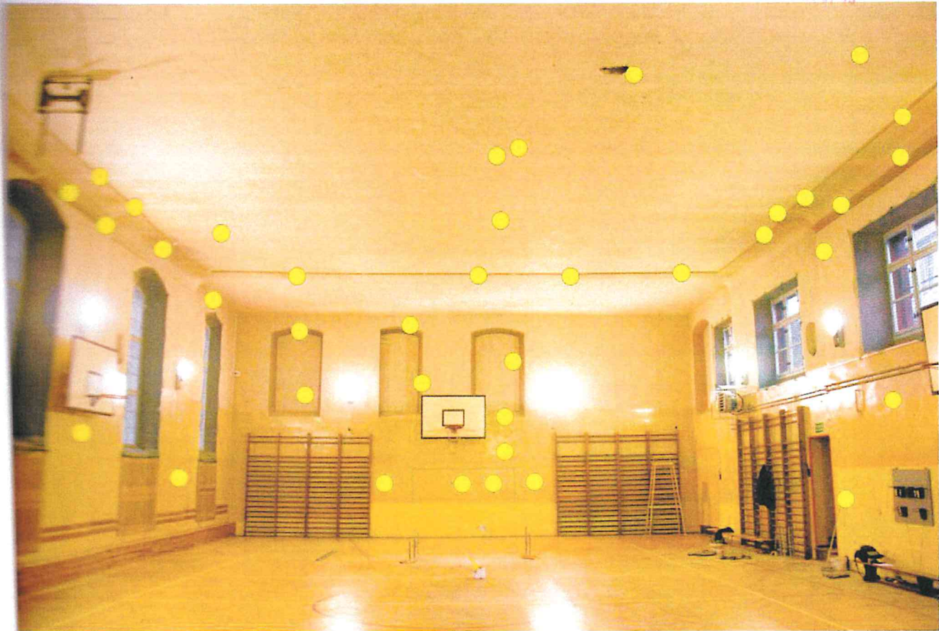
Widok na ścianę północną
