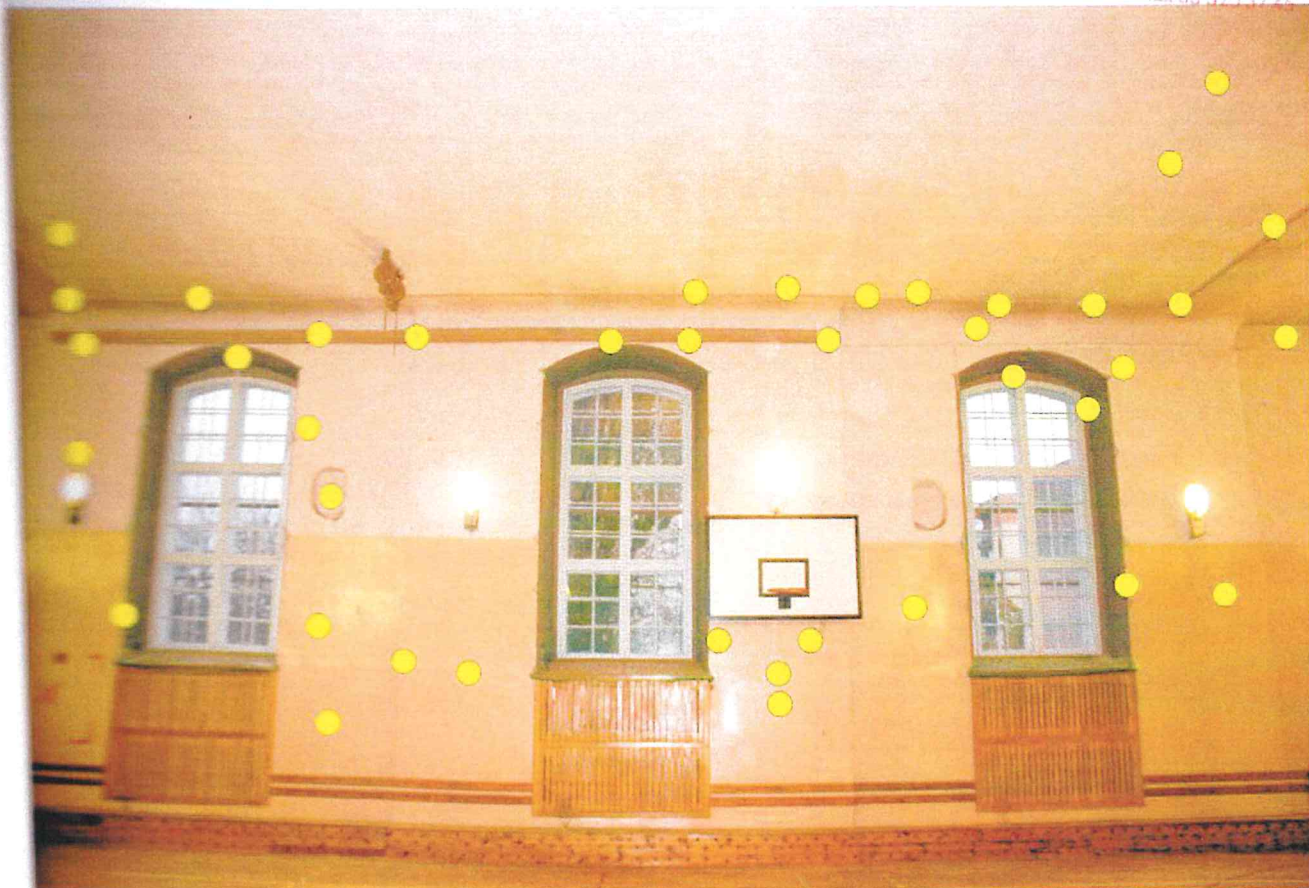
Widok na ścianę zachodnią.
