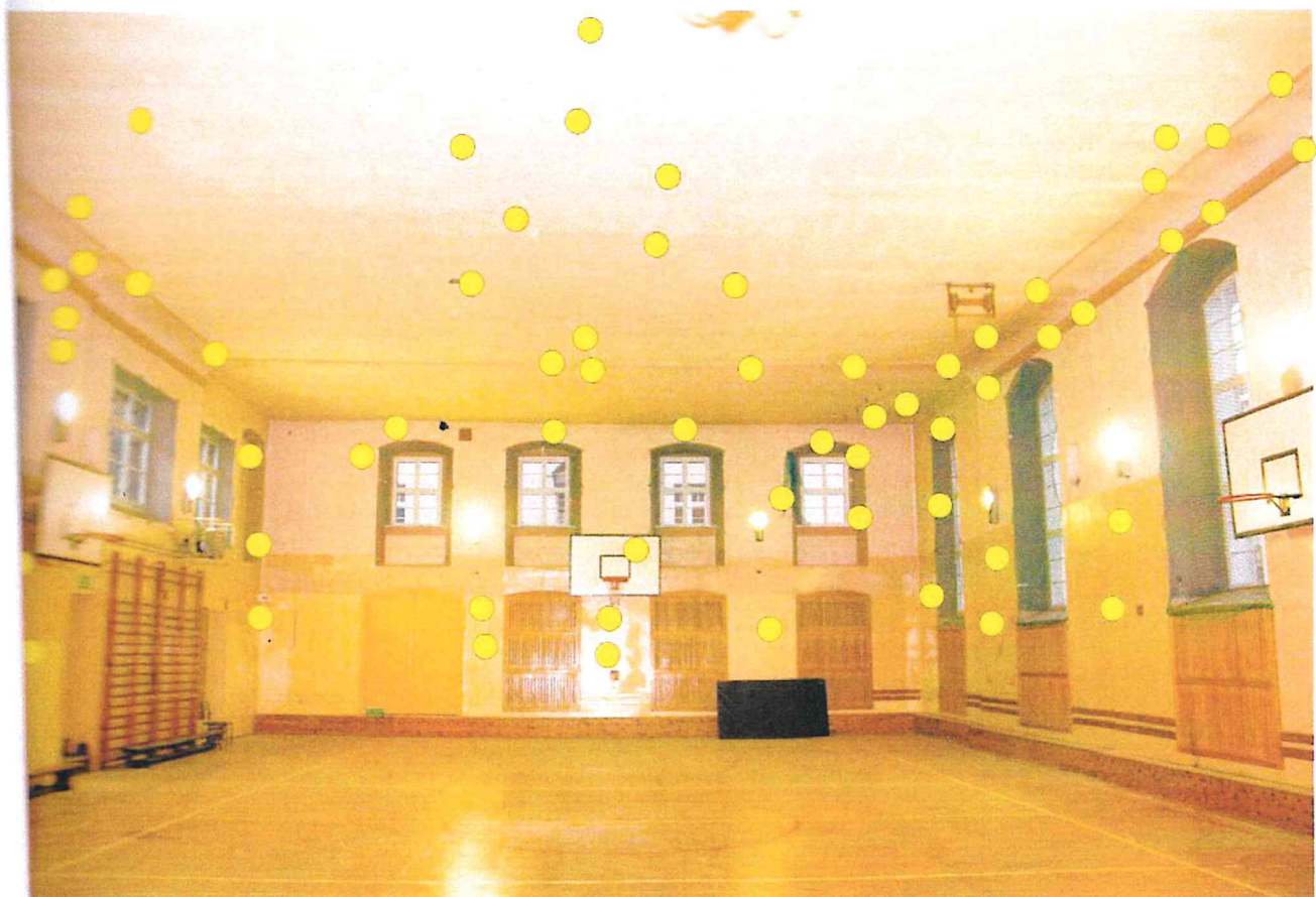
Widok na ścianę południową
