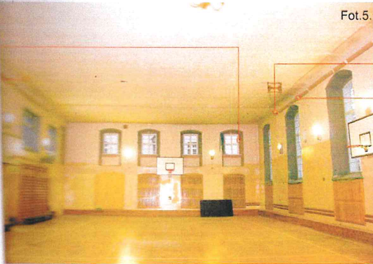
Wzrost na południową część sali gimnastycznej z zaznaczonymi miejscami umieszczonych na planszy zdjęć odkrywek stratygraficznych.
