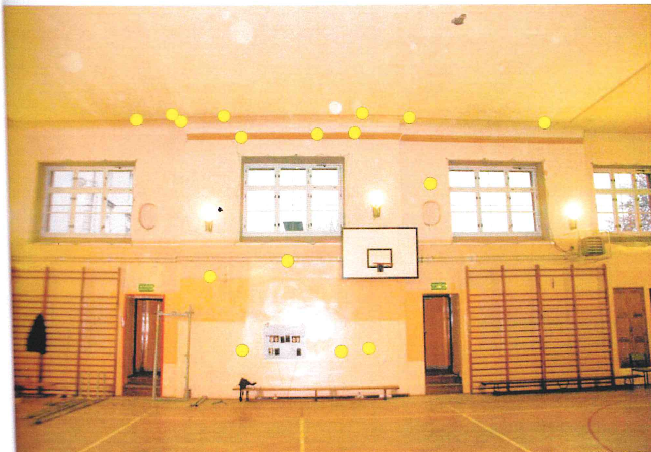
Widok na ścianę wschodnią.
