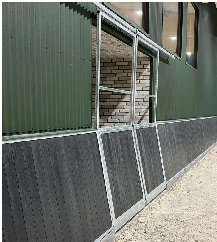
Podkonstrukcja pod lustro
