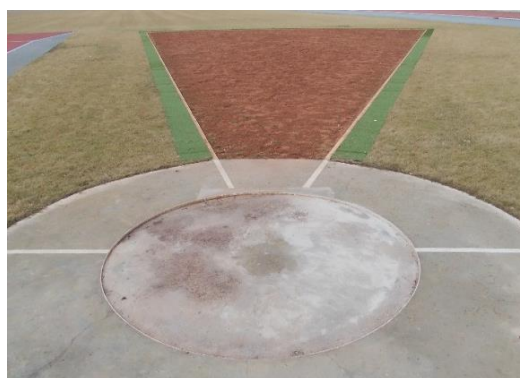
Rys. 9. Schemat malowania linii przy kole do pchnięcia kulą zamontowanego w otoczeniu nawierzchni syntetycznej i koła z obwódką betonową szer. 75 cm .
