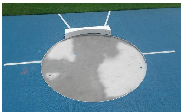
Rys. 9. Schemat malowania linii przy kole do pchnięcia kulą zamontowanego w otoczeniu nawierzchni syntetycznej i koła z obwódką betonową szer. 75 cm .
