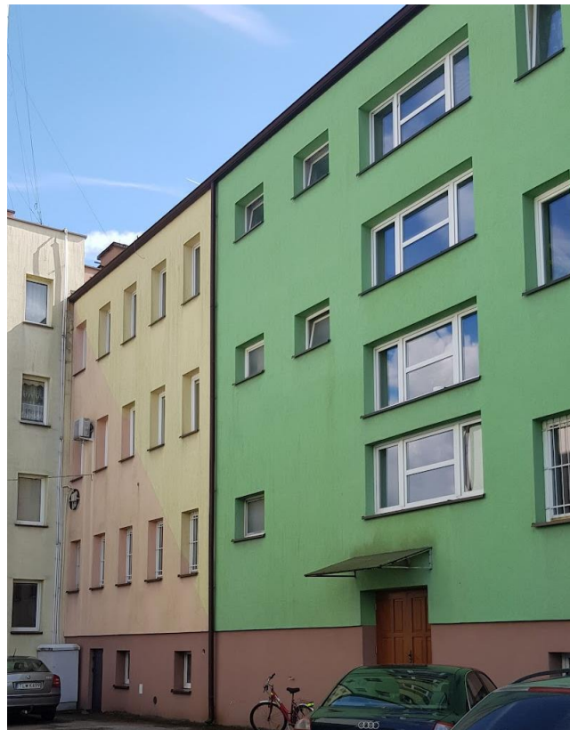
Fot. nr 2. Widok elewacji północnej
