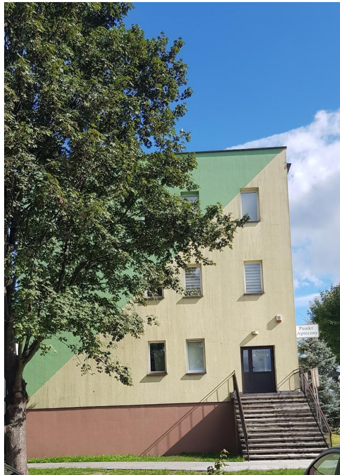
Fot. nr 3. Widok elewacji zachodniej
