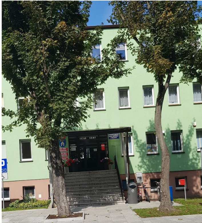
Fot. nr 1. Widok elewacji południowej
