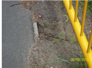
Przepusty - luźne kamienie zabruku do ponownego montażu
