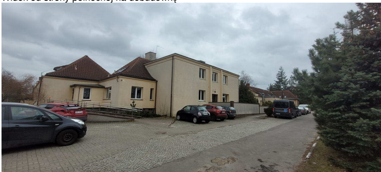
Widok od strony północnej na dobudówkę
