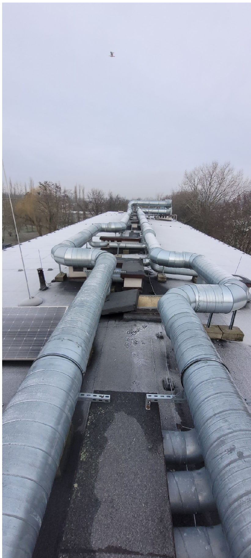
Widok z dachu w kierunku północnym.
