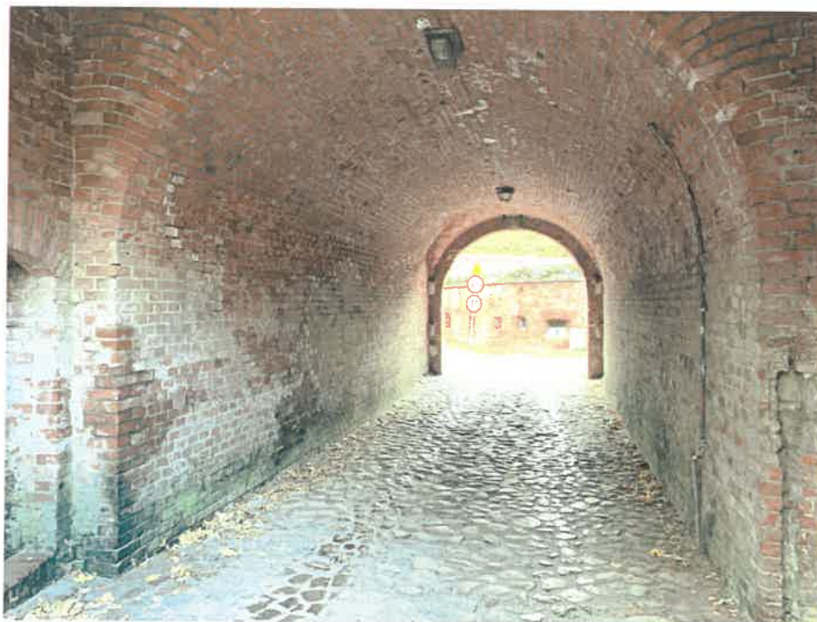
Fot 3. Przejazd widok ogólny
