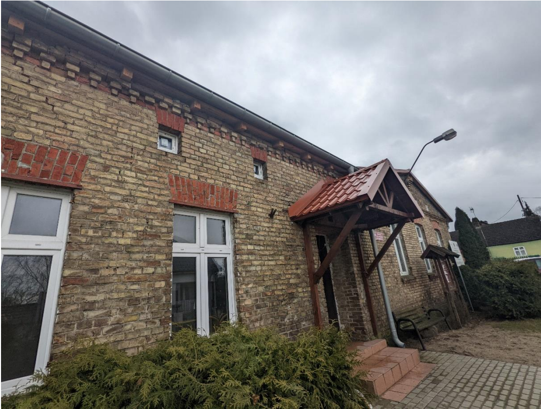
Fot.1 Fragment elewacji północnej.
