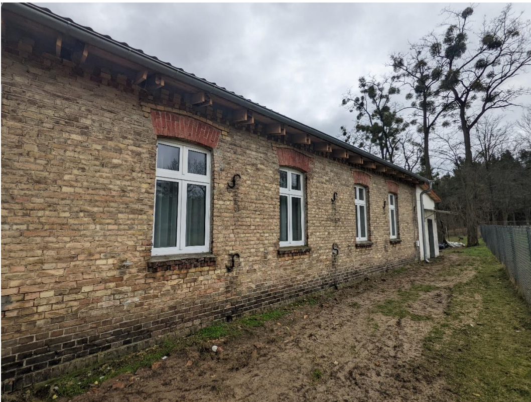
Fot.2 Elewacja zachodnia.
