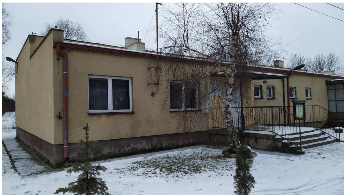
Fot.1. Naroże północno-wschodnie budynku.
