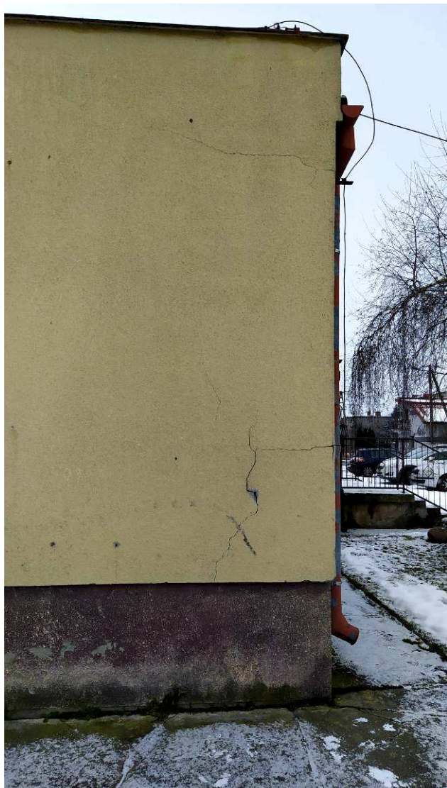
Fot.3. i Fot.4. Pęknięcia pionowe i poziome murów w strefie kotliny osiadań.
