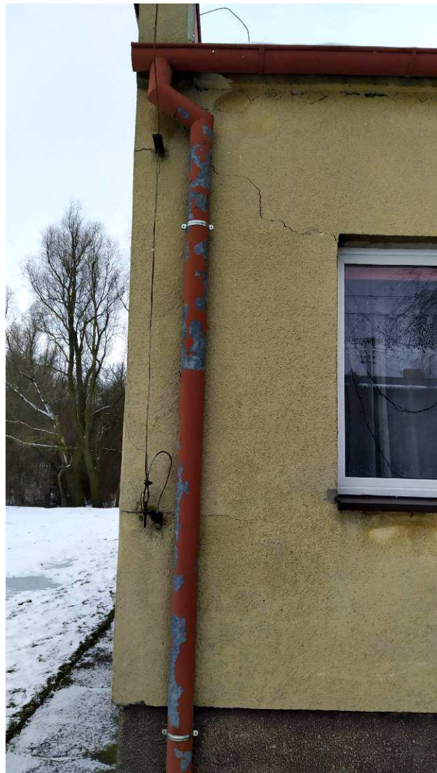
Fot.3. i Fot.4. Pęknięcia pionowe i poziome murów w strefie kotliny osiadań.
