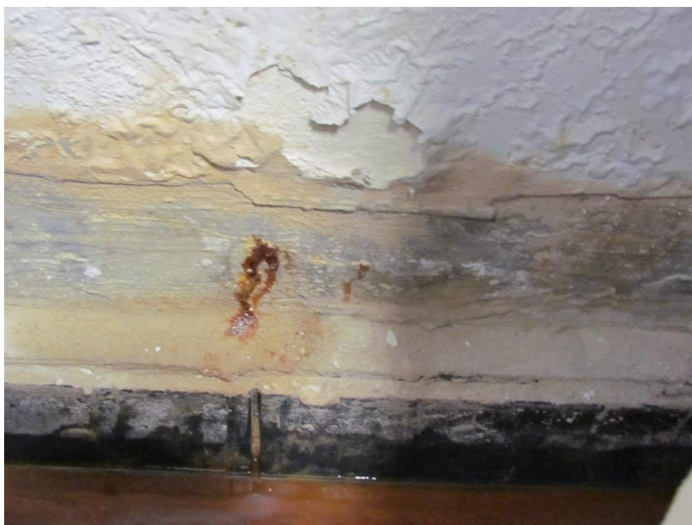
Fot.17. Miejsce styki korytka odwadniającego ze ścianą osłonową w osi 6-6.
