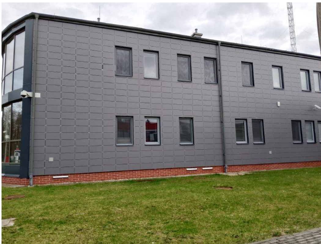
Fot.7. Elewacja północno-zachodnia – część podpiwniczona budynku.
