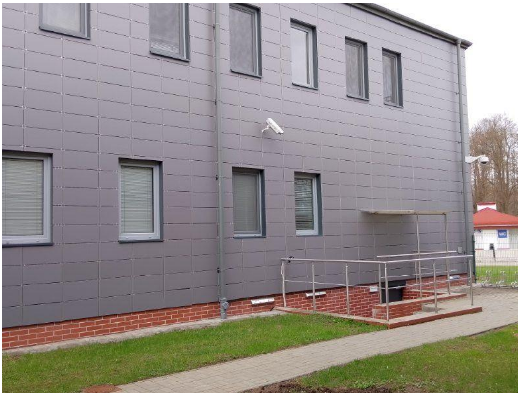
Fot.2. Elewacja południowo-wschodnia – część podpiwniczona budynku
