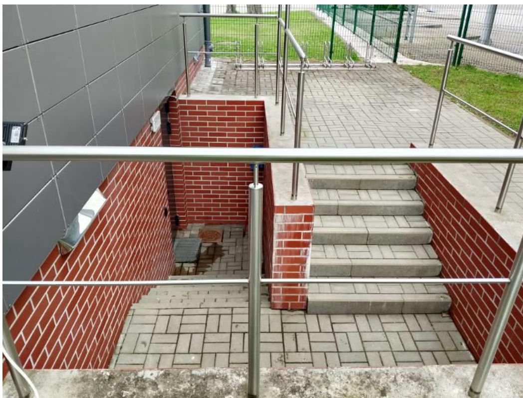
Fot.3. Elewacja południowo-wschodnia – zejście do węzła szatniowo-sanitarnego zlokalizowanego w piwnicy budynku
