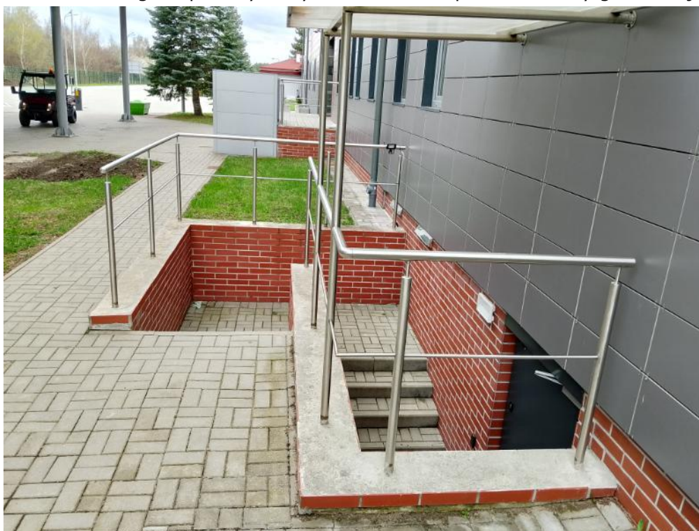
Fot.5. Elewacja południowo-wschodnia – zejście do węzła szatniowo-sanitarnego zlokalizowanego w piwnicy budynku. Widok od strony północnej.
