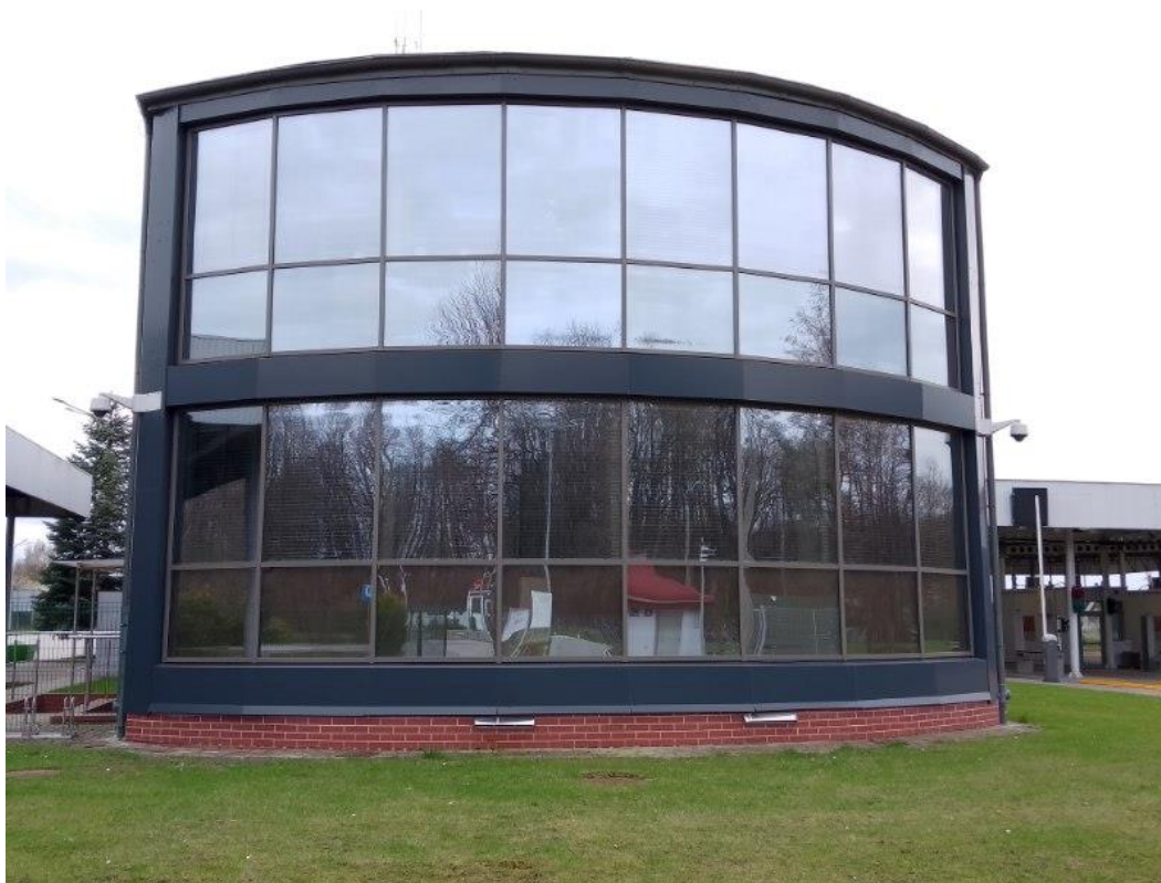
Fot.6. Elewacja północno-wschodnia (szczytowa) – część podpiwniczona budynku.
