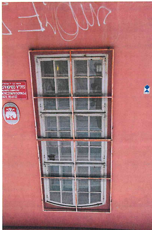
Okno elewacji północnej widok z zewnątrz.
