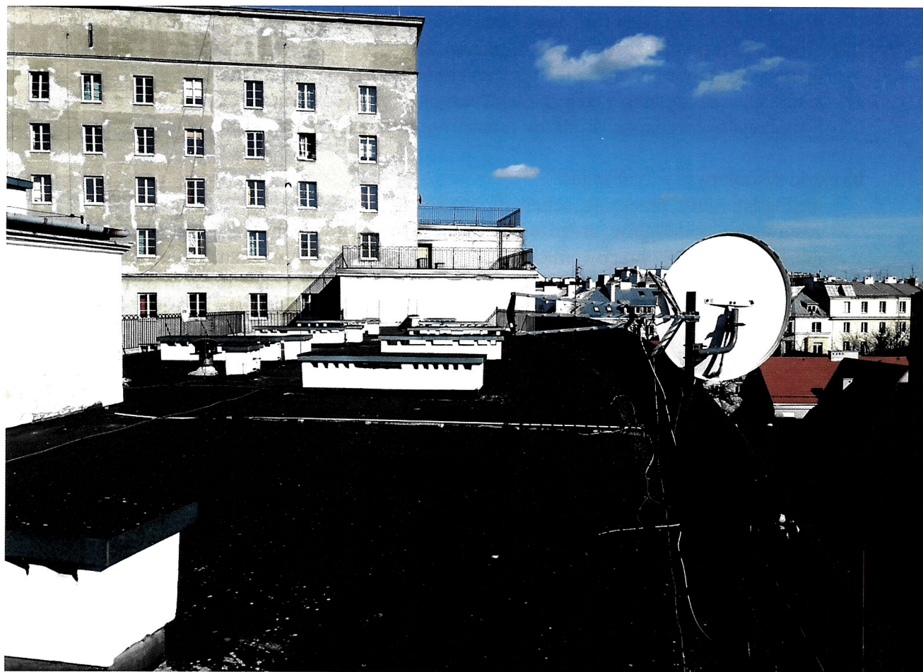
Zdj. 4. Istniejąca infrastruktura dachowa, m.in. mury, wentylatory, kominy, obróbki dachowe
