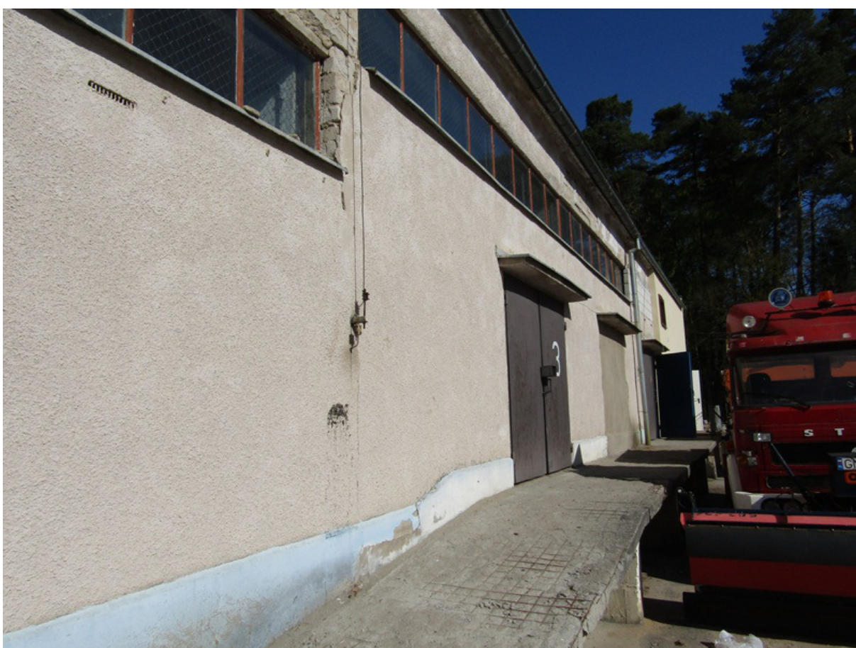
Fot. 2. Elewacja wschodnia cd. Na pierwszym planie pochylnia do wyburzenia.
