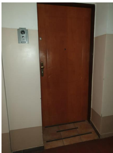
Drzwi wejściowe (2 szt.) z klatki do wymiany i podłączeniem do istniejącego systemu COMMAX:
