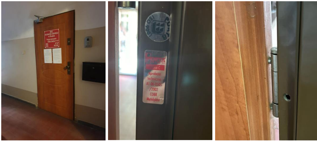
Drzwi do wymiany od podwórza wraz z demontażem wewnętrznych:
