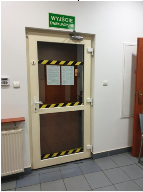
Drzwi wejściowe (2 szt.) z klatki do wymiany i podłączeniem do istniejącego systemu COMMAX:
