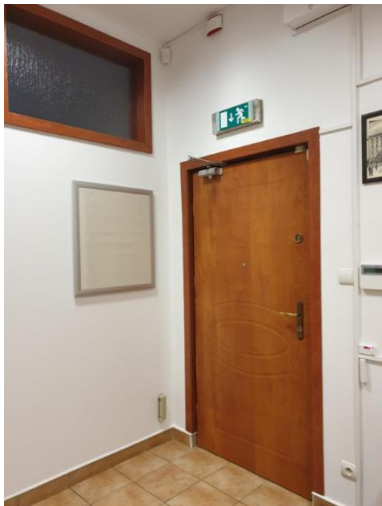
Drzwi wejściowe (2 szt.) z klatki do wymiany i podłączeniem do istniejącego systemu COMMAX:
