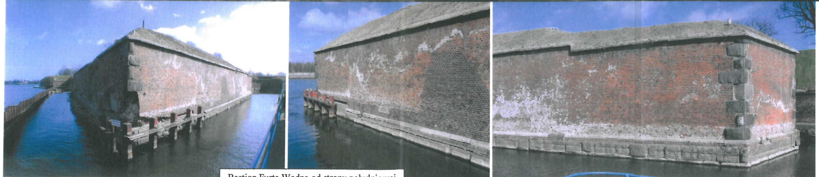
Bastion Furta Wodna od strony południowej
