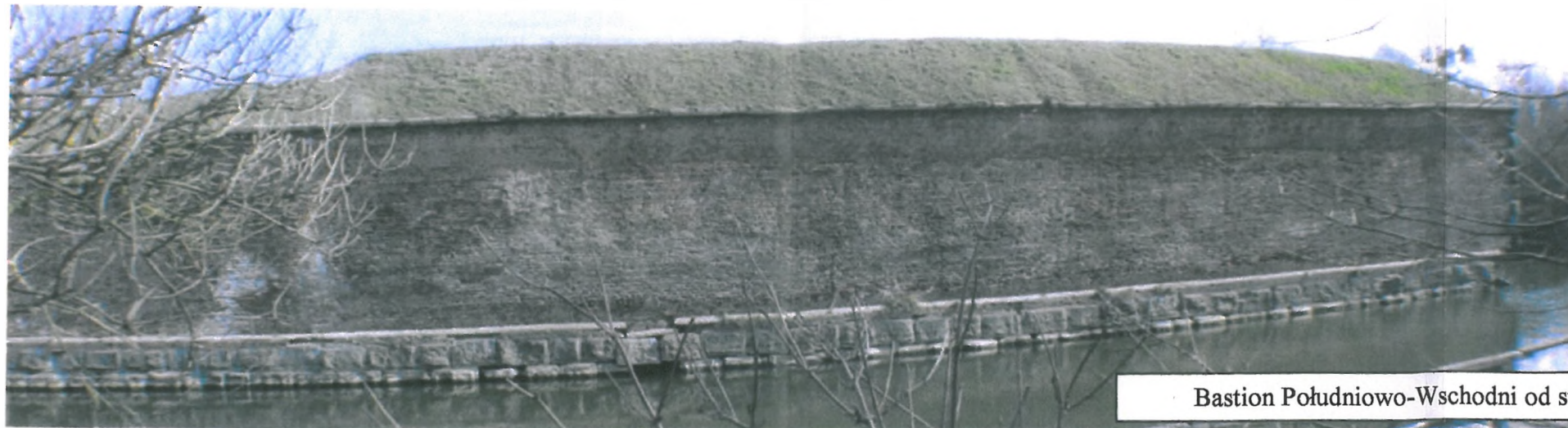
Widok od Strony południowej na Mur Fosbrei oraz bastiony Południowo-Wschodni i Furta Wodna
