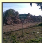
miejsce gromadzenia gruzu
