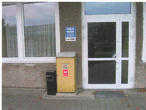
Przyłącze gazowe budynku A.
