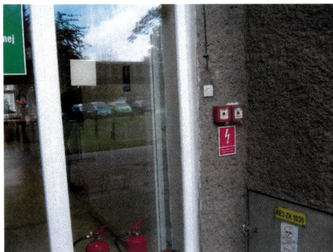
Przeciwpozarowy wyłącznik prądu.
