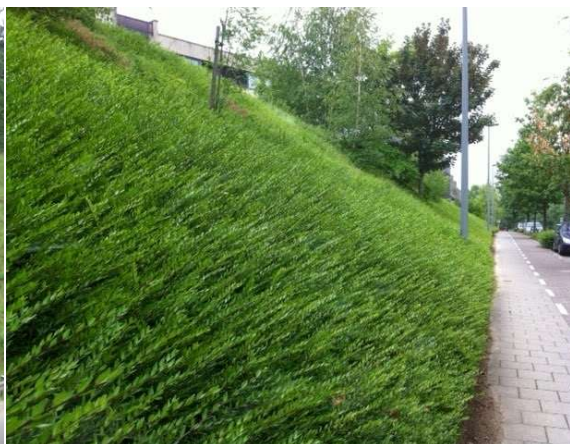
Fot. 45 Umocnienie skarpy z zastosowaniem zwartych nasadzeń krzewów [57]
