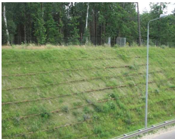
Fot. 44 Wzmocnienie stromej skarpy metodą faszynowania (fot. M. Kubus)
