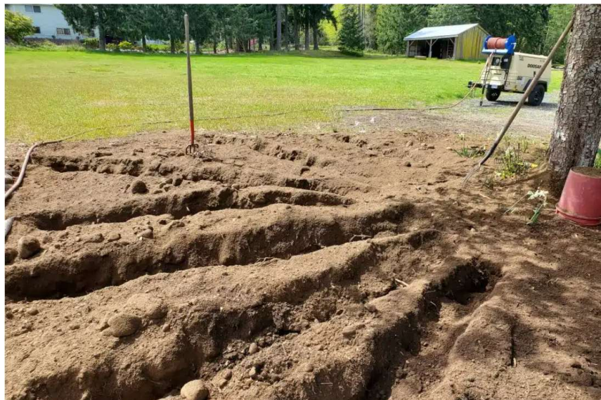
Fot. 18 Przykład przygotowania rowów napowietrzających z wykorzystaniem wydmuchiwania gleby sprężonym powietrzem - rowy przeznaczone do zasypania kruszywem [24]
