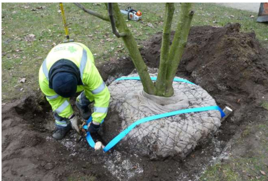
Fot. 40 Podziemne kotwienie drzew z zastosowaniem taśmy i palików [54]
