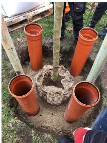
Fot. 19 Zastosowanie napowietrzania gleby przy nowych nasadzeniach, tzw. "system warszawski" – sposób ułożenia rur drenarskich przed zasypaniem ich kruszywem [25]
