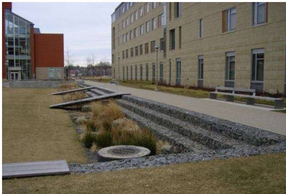
Fot. 23 Zastosowanie studzienek chłonnych w przestrzeni osiedlowej [30]
