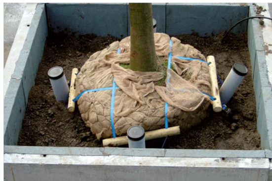
Fot. 41 Podziemne kotwienie drzew w misach ziemnych z zastosowaniem palików i taśmy [54]
