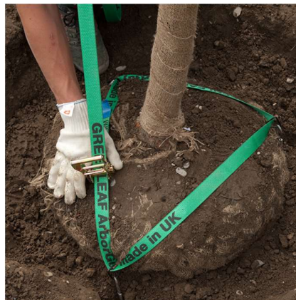
Fot. 43 Przykład zastosowania systemu kotwienia brył korzeniowych z wykorzystaniem kotew [55]
