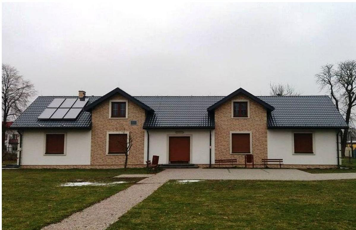
Dach strony południowej przeznaczony do montażu paneli fotowoltaicznych.
