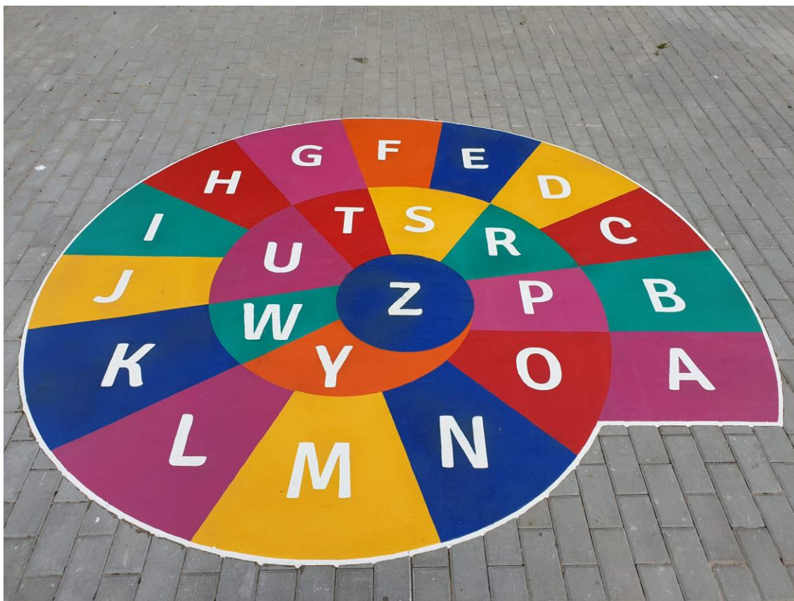
Fot: Przykładowe wykonanie grafiki z masy termoplastycznej na nawierzchni z kostki z zastosowaniem podkładu z masy chemoutwardzalnej.
