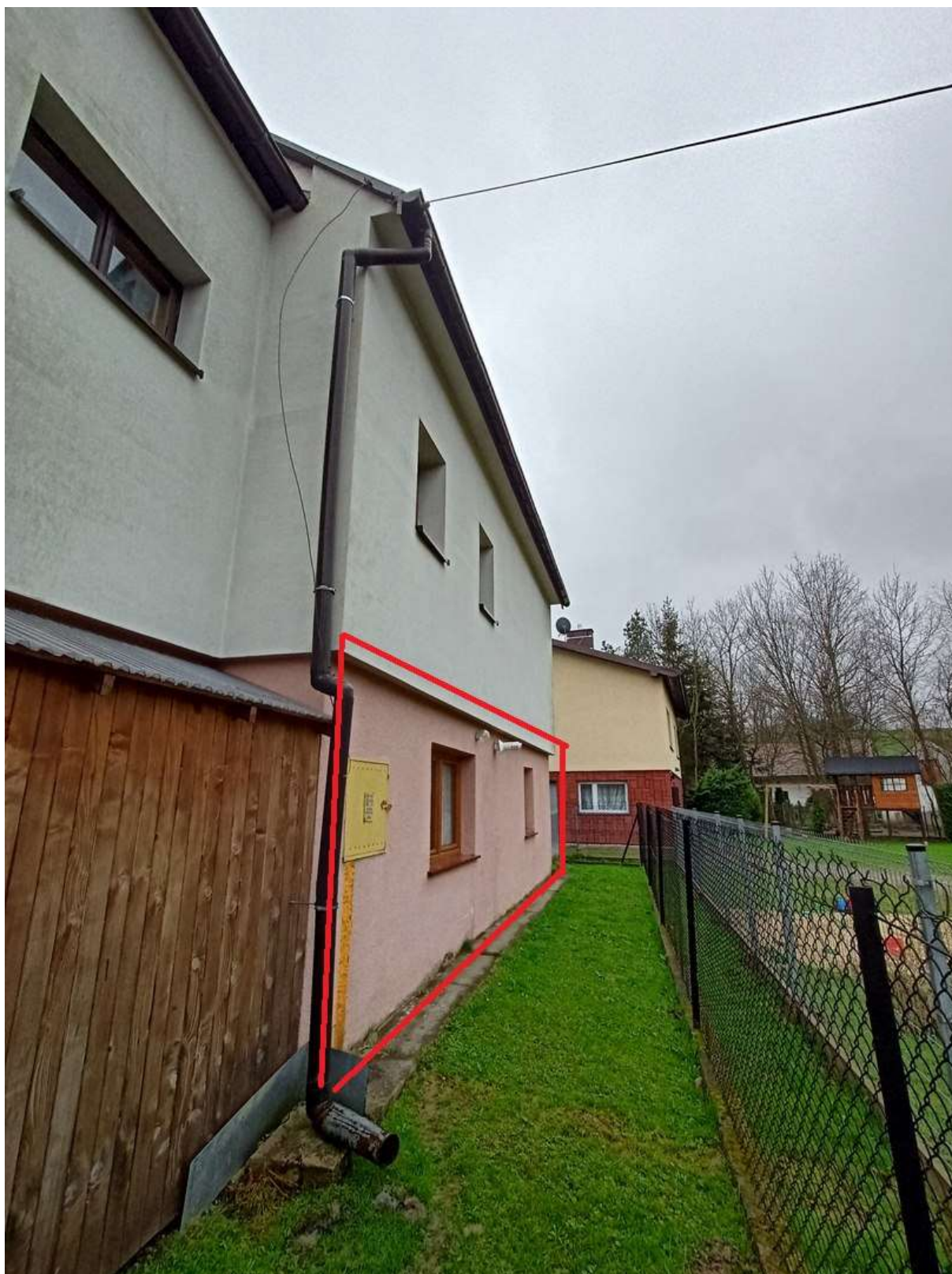
Rysunek 1 Zakres modernizacji – docieplenie ścian zewnętrznych (ściana północno-zachodnia)
