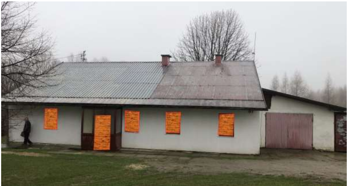
Rysunek 1 Zakres modernizacji - wymiana okien (elewacja północno-zachodnia szt.4), wymiana drzwi zewnętrznych (szt.1)
