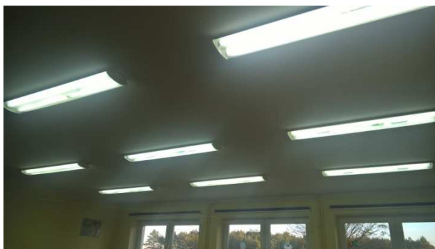
Zdj. 1. Oprawy świetlówkowe na 2xT8 36 i 2x58W zamontowane w salach lekcyjnych
