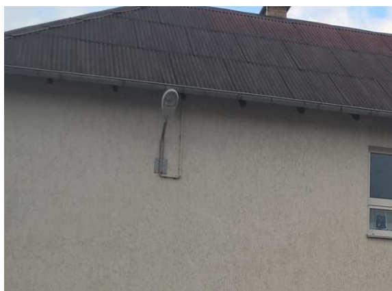
Zdj. 2. Oprawa oświetlenia terenu HSP 250W – do wymiany.
