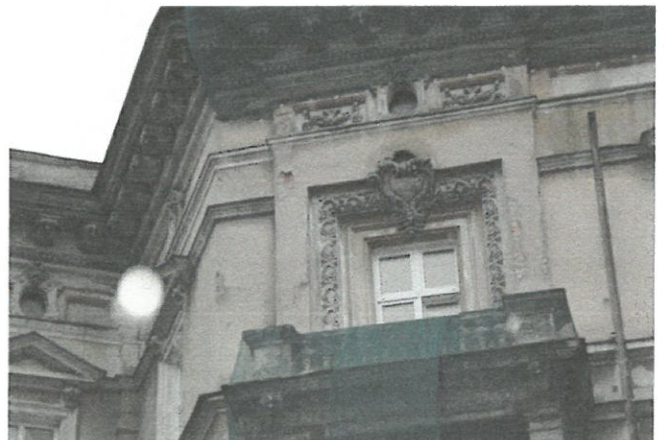
Liczne ubytki tynku w strefach nadprożowych.
