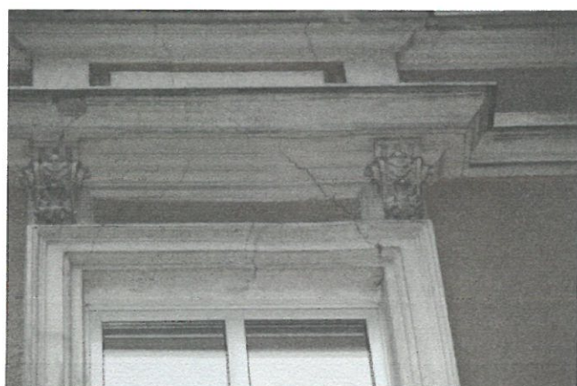
Zarysowania w strefie nadprożowej na elewacji frontowej od strony ul. Jana Matejki.
