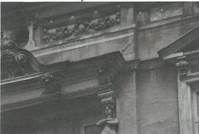
Liczne ubytki tynku w strefach nadprożowych.
