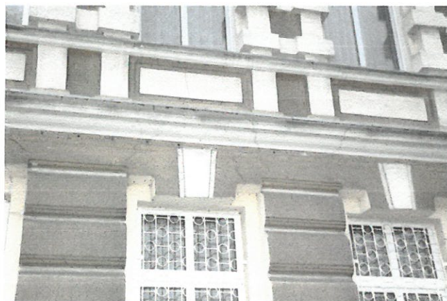
Elewacja frontowa od strony ul. Żubrów – zarysowania nadproży.
