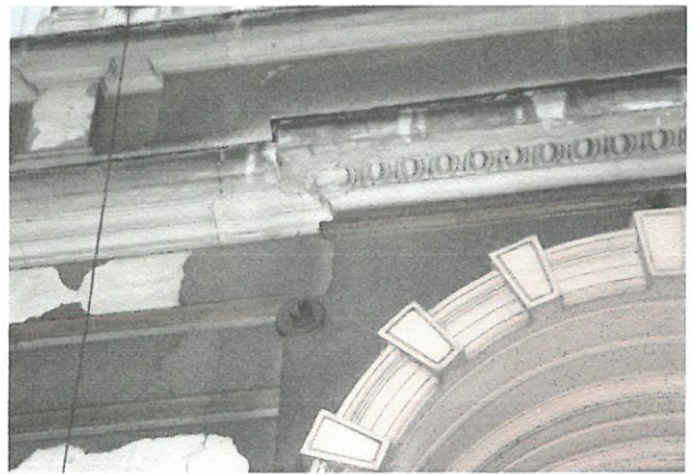
Widoczne zarysowania wokół narożnika okiennego oraz przy wejściu głównym.
