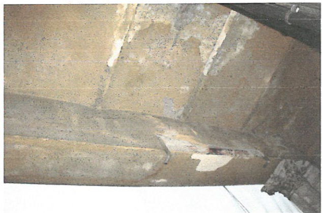
Zacieki poprzez nieszczelności przy przejściach rur odprowadzających wody opadowe.
