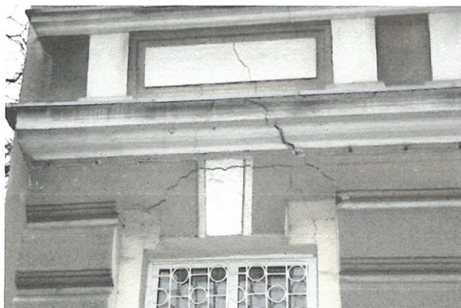
Elewacja frontowa od strony ul. Żubrów – zarysowania nadproży.
