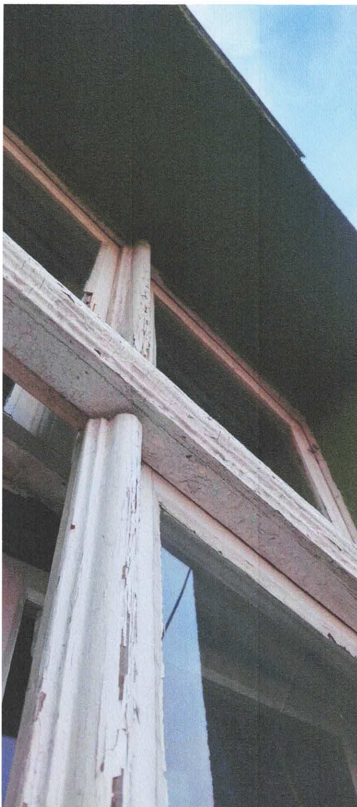
Fot. 4 - widok słupka i ślemienia
