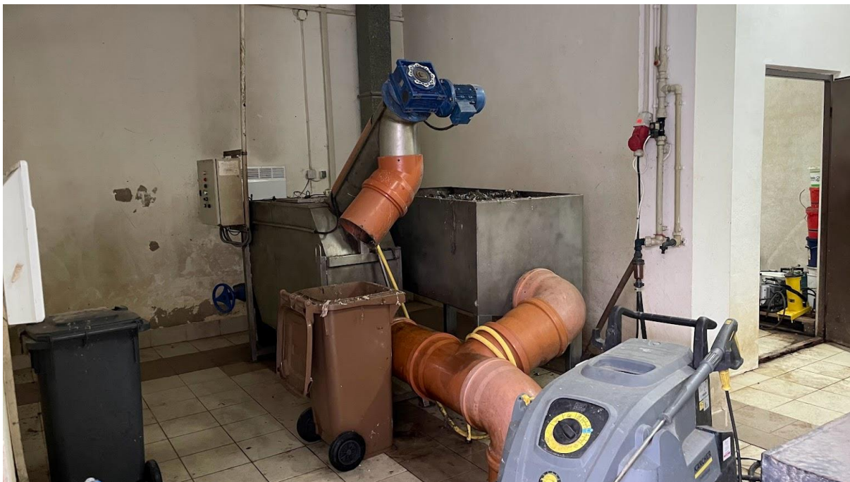
Rysunek 2. Sito mechaniczno – spiralne zlokalizowane w budynku oczyszczalni ścieków Lipnica Wielka. (Poziom 0)
