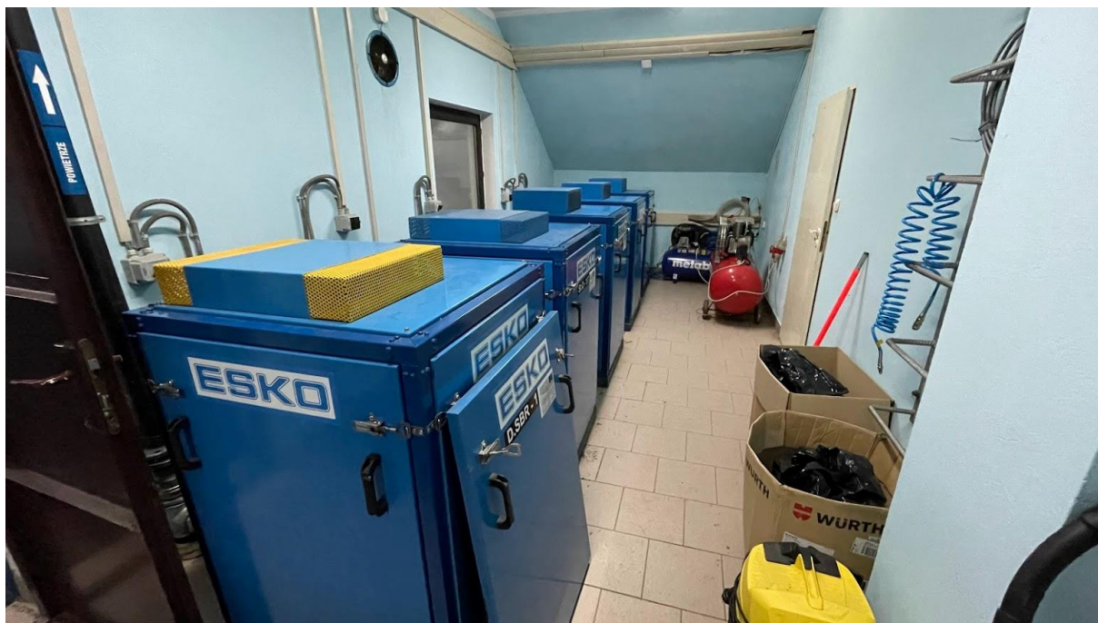
Rysunek 5. Stacja dmuchaw zlokalizowana w budynku oczyszczalni ścieków Lipnica Wielka (poziom +I).
