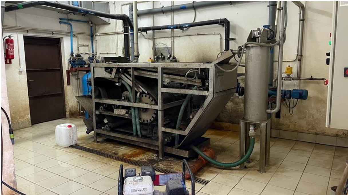
Rysunek 6. Stacja odwadniania osadu znajdująca się w budynku oczyszczalni ścieków Lipnica Wielka. (Poziom 0)
