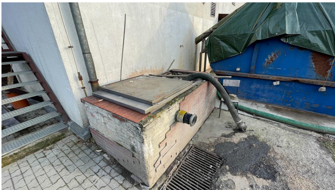
Rysunek 3. Punkt zlewny ścieków dowożonych do oczyszczalni ścieków Lipnica Wielka.
