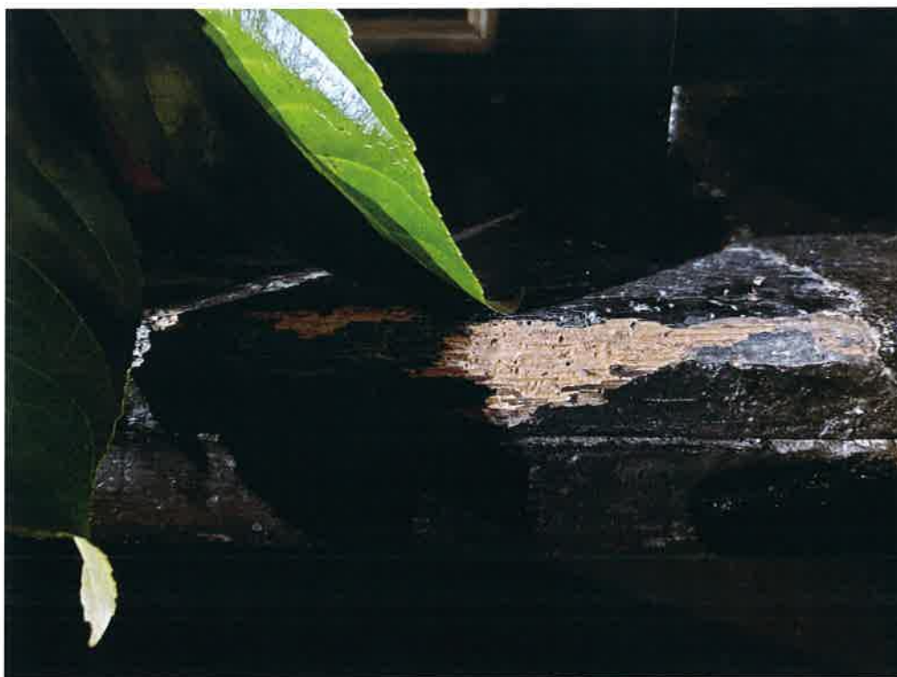
fot. 1 Widoczne zniszczenia drewnianej płyty leżącej bezpośrednio na mensie
