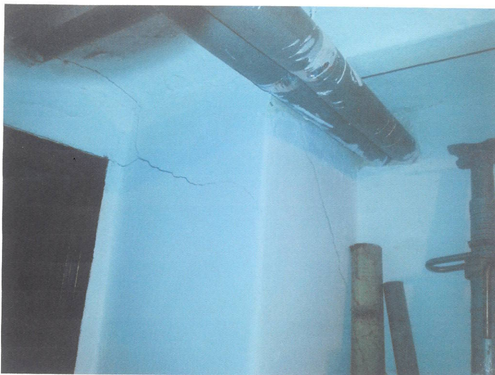
9. Magazyn dowodów rzeczowych (przy wejściu) (widok w kierunku północno-wschodnim)
