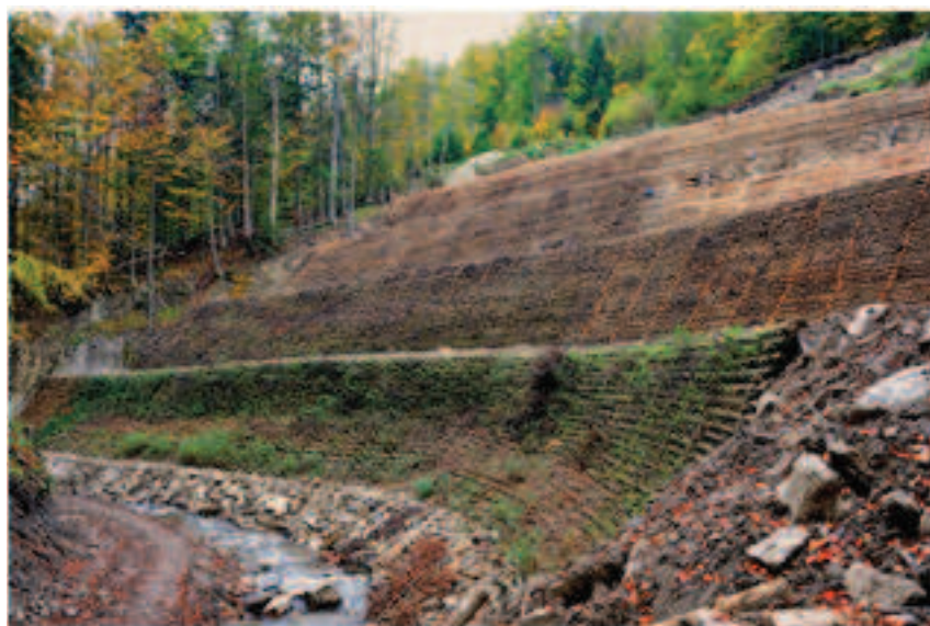
Kaszyca z pędami wierzby zabezpieczająca osuwisko pod drogą podcinaną przez ciek – pędy rozpoczęły wegetację jeszcze przed zakończeniem budowli. Nadleśnictwo Stuposiany. Źródło: Archiwum CKPS.
