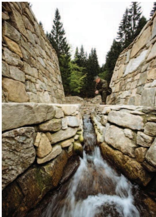
Widok na zaporę czołową dawnego zbiornika na cieku do spławu drewna przerobionego na zbiornik przeciwpowodziowy – Nadleśnictwo Międzylesie. Źródło: Archiwum CKPŚ. (rys. na górze)
