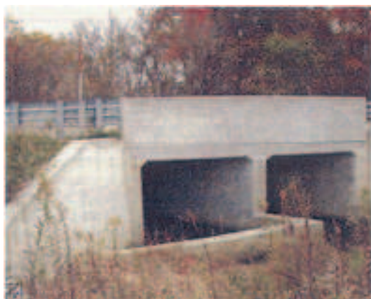
Przykłady ścianek ukierunkowujących niski przepływ do jednej komory przepustu (przepust dwukomorowy na zdjęciu i trzykomorowy na rysunku). Źródło: „Metody hydraulicznego projektowania przepustów z uwzględnieniem morfologii cieku i wymogów związanych ze swobodnym przepływem ryb.” A.J. Kosicki w „Hydraulika, hydrologia, hydrogeologia”, rys. na podstawie źródła P. Włodarczyk.
