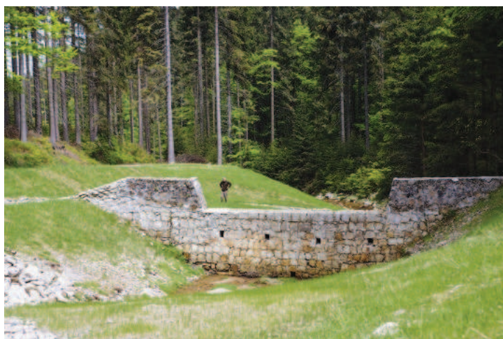
Zapora przeciwrumowskowa w Nadleśnictwie Łądek Zdrój z oczyszczoną w ramach projektu retencji górskiej niecką (min. funkcja przeciwpowodziowa) i dobudowaną przeplawką. Zapora przerywa ciągłość transportu rumowiska - należy monitorować potrzebę alimentacji rumoszu poniżej zapory. Źródło: Archiwum CKPŚ.
