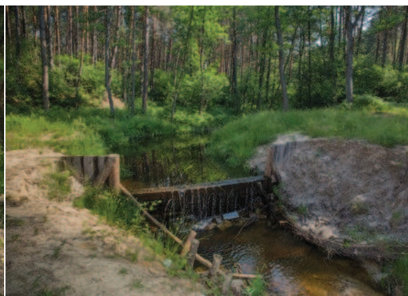
Widoczna erozja dna i skarp prowadząca do osłabienia konstrukcji. Źródło: Archiwum CKPS
