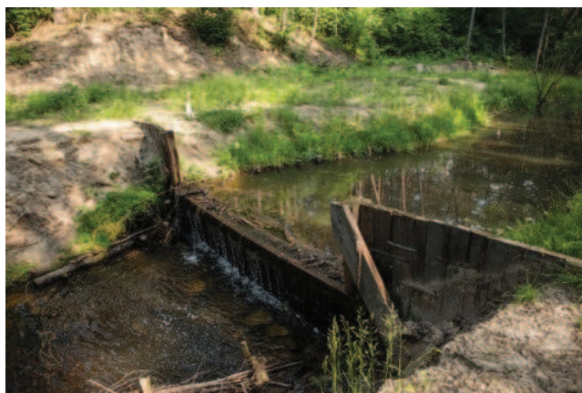
Próg wygięty pod presją naporu wody. Źródło: Archiwum CKPS.
