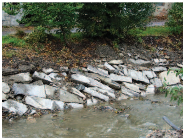
Narzut kamienny z dużych głazów układany mechanicznie – Czechy. Źródło: Archiwum CKPS
