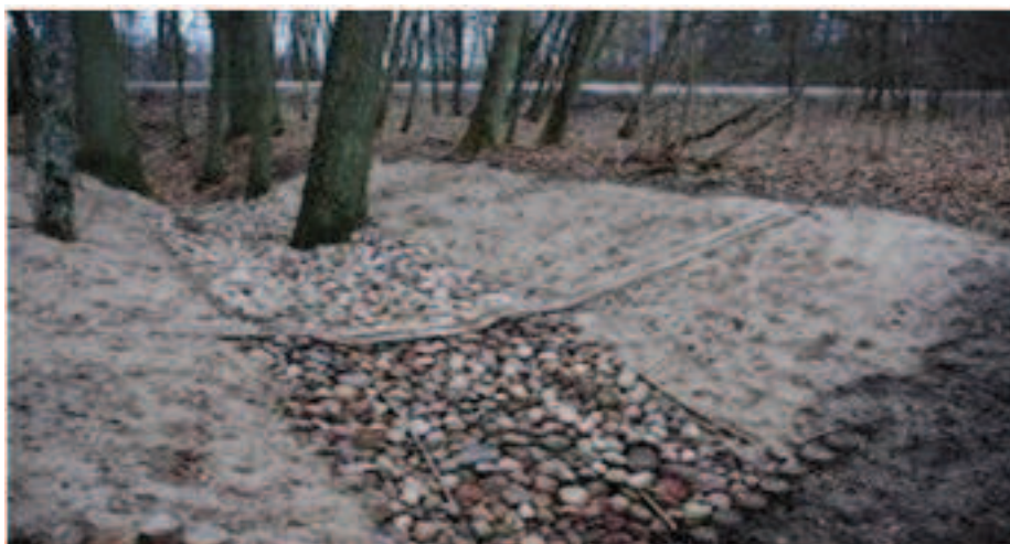
Bystrotok faszynowo-kamienny z drewnianą ścianką szczelną i palisadą drewnianą w Nadleśnictwie Strzałowo (fot. M. Goździk)
