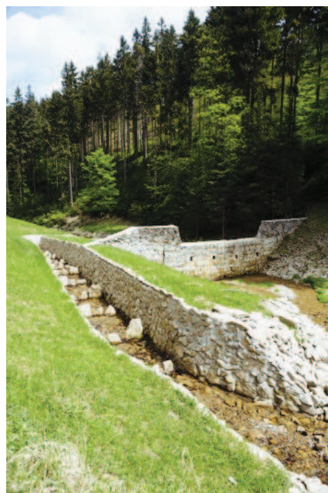
Zapora przeciwrumowskowa w Nadleśnictwie Łądek Zdrój z oczyszczoną w ramach projektu retencji górskiej niecką (min. funkcja przeciwpowodziowa) i dobudowaną przeplawką. Zapora przerywa ciągłość transportu rumowiska - należy monitorować potrzebę alimentacji rumoszu poniżej zapory. Źródło: Archiwum CKPŚ.
