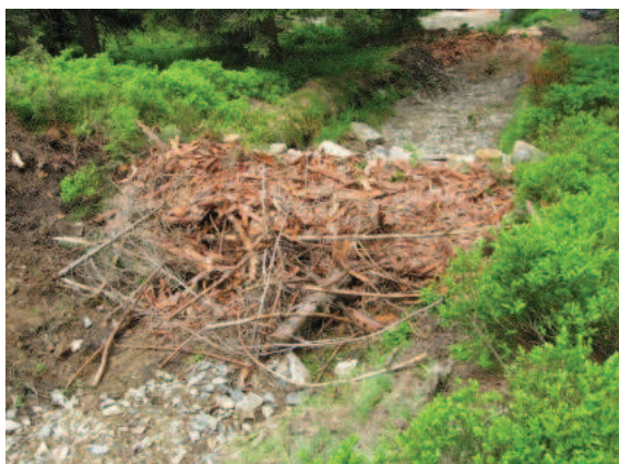
Przegrody drewniane wypełnione gałęziówką ubezpieczone narzutem kamiennym na szlakach zrywkowych (widok z góry i z dołu) (fot. N-ctwo Łądek Zdrój, RDLP Wrocław)
