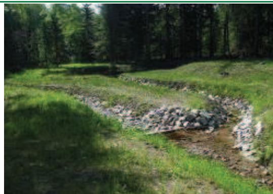
Podział wody na cieku głównym – dolot do zbiorników bocznych w N-ctwie Szklarska Poręba. Źródło: Archiwum CKPŚ.
