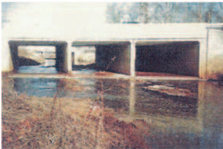
Błędnie zaprojektowana rzędna dna rozlewająca wodę w cieku szerzej niż naturalne koryto. Źródło: „Metody hydraulicznego projektowania przepustów z uwzględnieniem morfologii cieku i wymogów związanych ze swobodnym przepływem ryb.” A.J. Kosicki w „Hydraulika, hydrologia, hydrogeologia”
