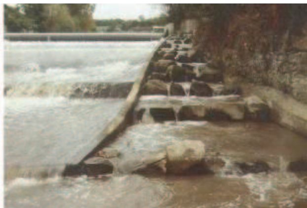
Przepławka kaskadowa przy budowlu hydrotechnicznej. (Jelonek 2008)
