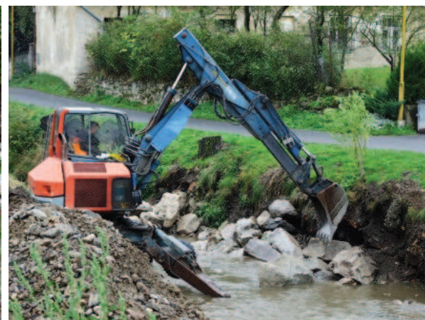
Narzut kamienny z dużych głazów układany mechanicznie – Czechy. Źródło: Archiwum CKPS
