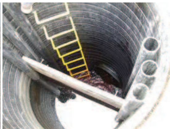
Studnia piętrząco-spustowa w trakcie budowy, widoczne kłamy zejściowe (fot. N-ctwo Lwówek Śląski i Szklarska Poręba)
