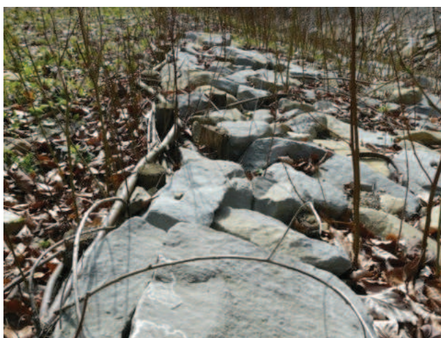
Zabezpieczony faszyną narzut kamienny z nasadzeniami wierzbowymi. Źródło: Archiwum CKPS
