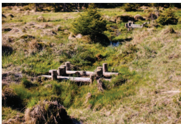
Zarastający rów odwadniający dzięki zastosowaniu przytępiających ziemno-drewnianych – Nadleśnictwo Szklarska Poręba. Źródło: Archiwum CKPŚ
