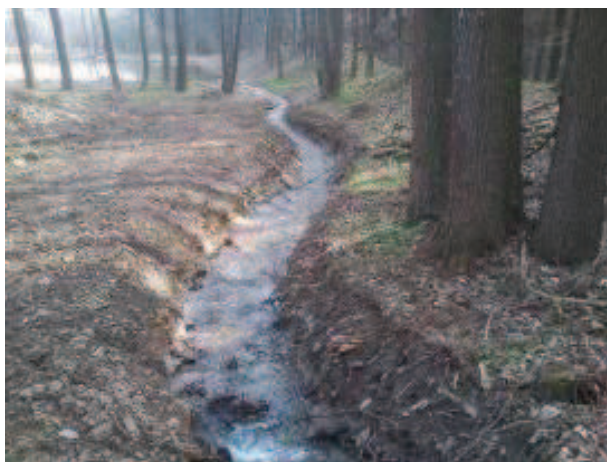
Kanał ziemny łączący 2 zbiorniki (N-ctwo Świdnica)
