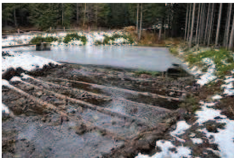
Przelewy górne w zbiornikach w N-ctwie Bielsko
