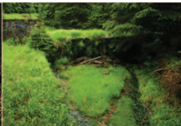
Jedna z zapór w Nadleśnictwie Łądek Zdrój wypełniona całkowicie, na której zaszła sukcesja roślinności – takie obiekty niczemu już nie służą. Źródło: Archiwum CKPŚ.
