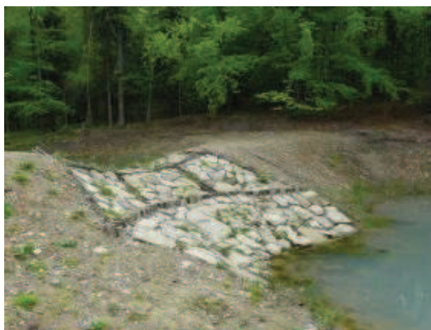
Przelewy górne w zbiornikach w N-ctwie Bielsko
