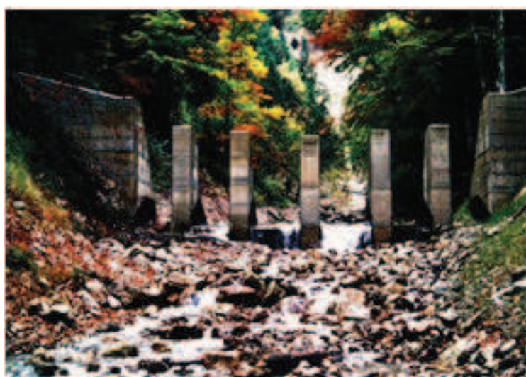
Zmodernizowana zapora szczelinowa (Austria)
