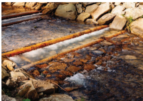
Gurt ubezpieczający próg – gurt zabezpieczony narzutem kamiennym – rozwiązanie podobne do rys na rycinie a) Źródło: Archiwum CKPS
