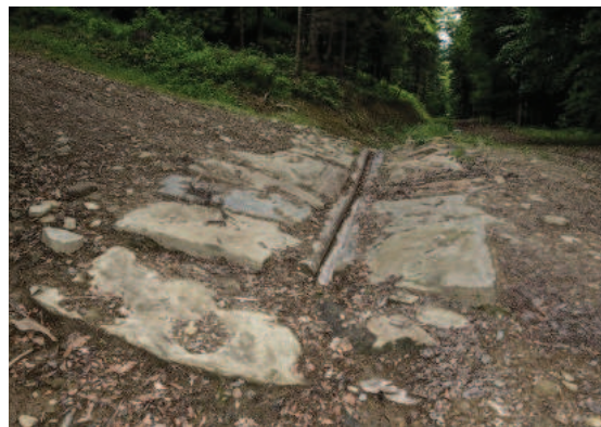
Wodospust odprowadzający wodę z drogi do lasu.
