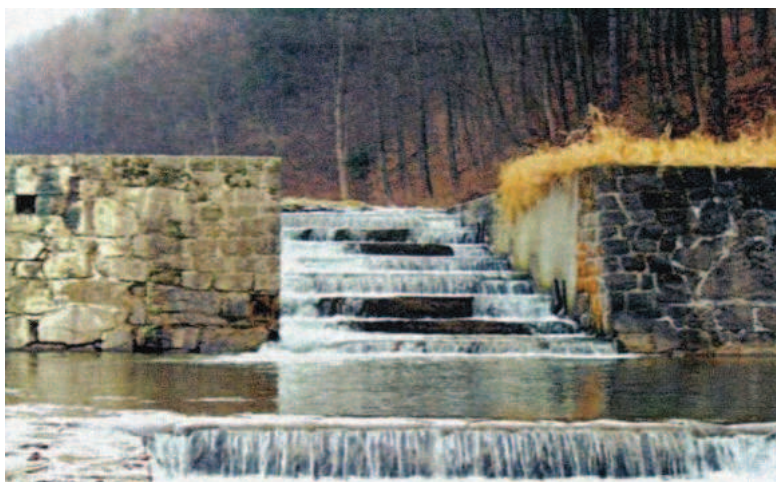
Przepławka wykonana w zaprze przeciwrumowiskowej na potoku Wirchomla. Źródło: Archiwum CKPŚ.
