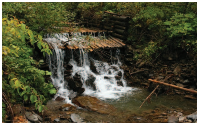
Tego typu konstrukcje są mało odporne na niszczące działanie wód wezbraniowych. Źródło: Archiwum CKPS
