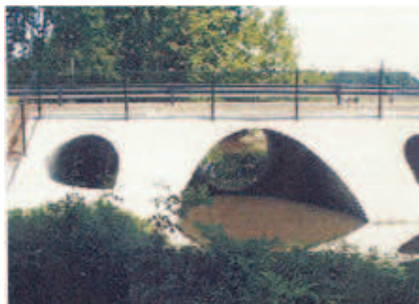
Przykłady wielootworowych przepustów z rezerwową przepustowością na wody powodziowe. Źródło: „Metody hydraulicznego projektowania przepustów z uwzględnieniem morfologii cieku i wymogów związanych ze swobodnym przepływem ryb.” A.J. Kosicki w „Hydraulika, hydrologia, hydrogeologia”
