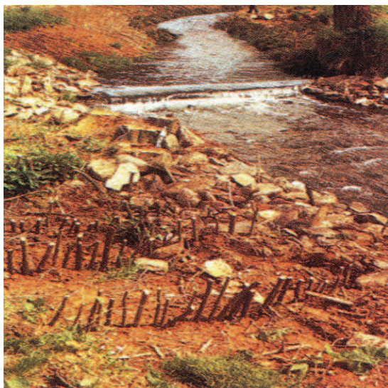
Płotek ze zrzesów wierzbowych tuż po wykonaniu (Begemann i Schiechl 1999)
