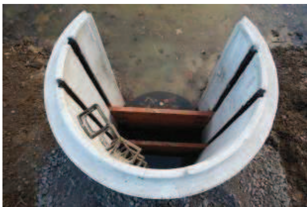
Studnia piętrząco-spustowa w trakcie budowy, widoczne kłamy zejściowe (fot. N-ctwo Lwówek Śląski i Szklarska Poręba)
