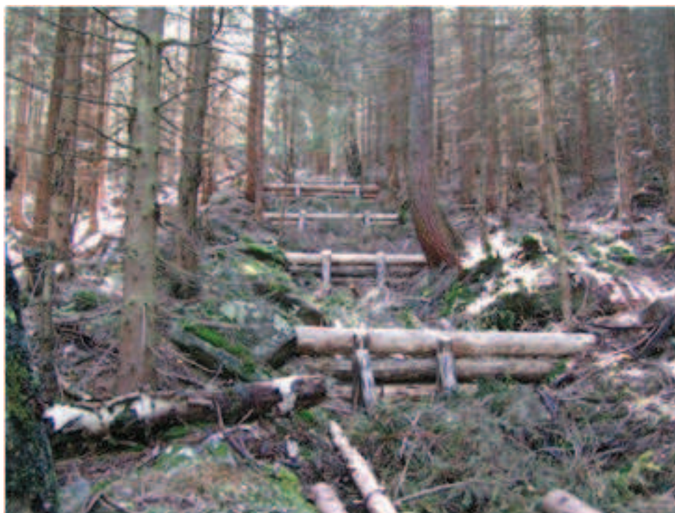
Przegrody drewniane wypełnione gałęziówką na szlakach zrywkowych
