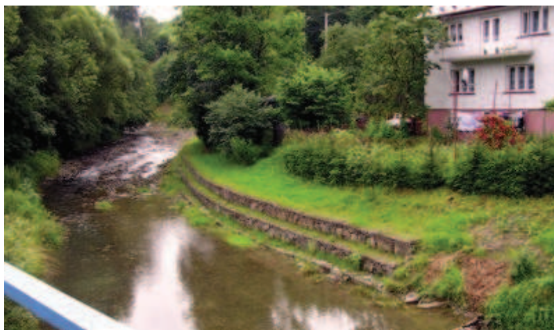
Fot. 3. Zabezpieczenie konstrukcji budowlanych
