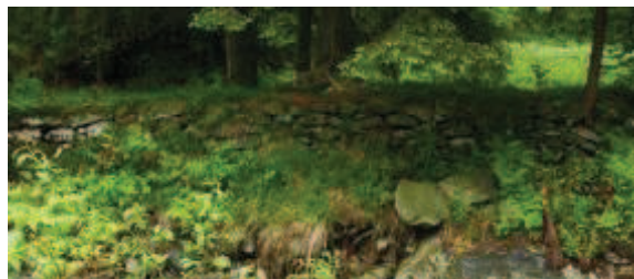
Murki kamienne bez zaprawy w N-ctwie Łądek Zdrój (góra) i Węgierska Górka (po prawej) (fot. M. Goździk)
