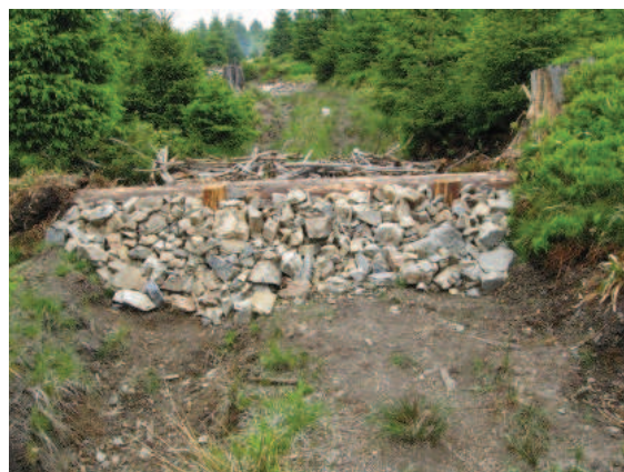
Przegrody drewniane wypełnione gałęziówką ubezpieczone narzutem kamiennym na szlakach zrywkowych (widok z góry i z dołu) (fot. N-ctwo Łądek Zdrój, RDLP Wrocław)
