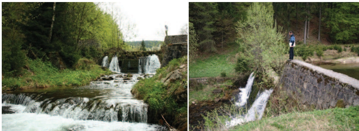
Bardzo stara zaniedbana zapora kwalifikująca się do rozebrania – Nadleśnictwo Łądek Zdrój. Na decyzje o rozbiórce zapory powinny mieć wpływ nie tylko stan obiektu, ale jego funkcje i dysfunkcje gospodarczo – przyrodnicze w otoczeniu. Źródło: Archiwum CKPŚ.
