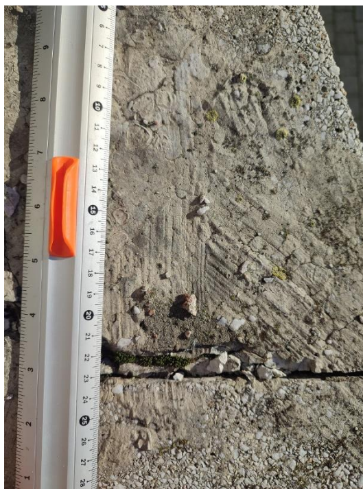
Fot. 25 Połączenie płyt pamiątkowych widok z góry
