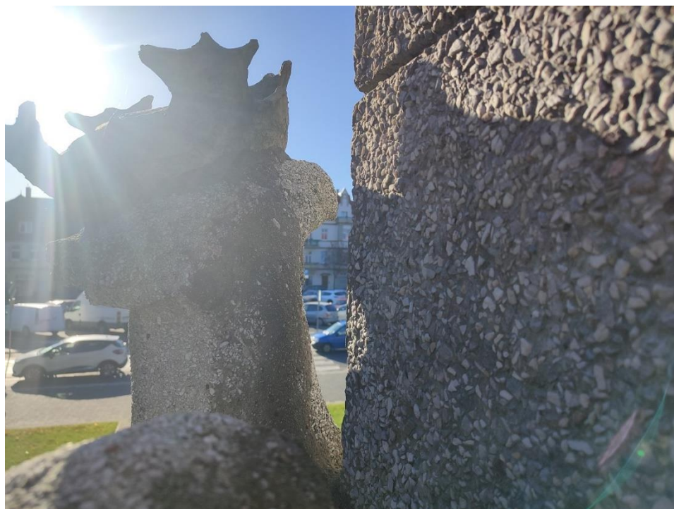
Fot. 38 Korona orła spękana, w miejscach zacięzionych wyraźna wegetacja mchów i porostów.
