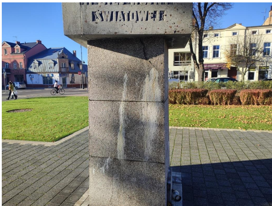
Fot. 9 Liczne wycieki i wykwyty od strony wschodniej. Pęknięcie na 3 segmencie poniżej płyty pamiątkowej długości kilkudziesięciu centymetrów
