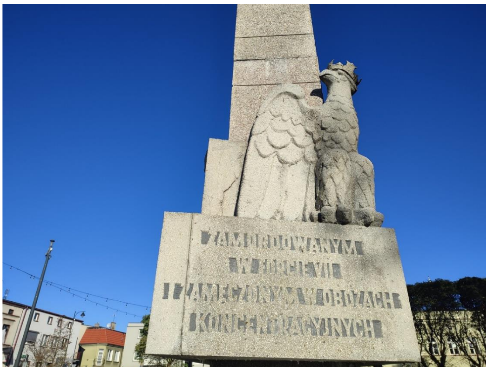
Fot. 27 Wyraźna szczelina pionowa na styku dwóch płyt pamiątkowych. Po lewej stronie orła odpajający się kawałek płyty.
