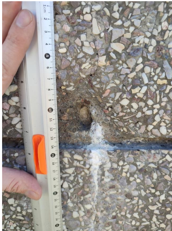
Fot. 15 Zbliżenie na wykruszenie ze zdjęcia nr 14, trójkąt o wymiarach podstawie i wysokości 7cm.
