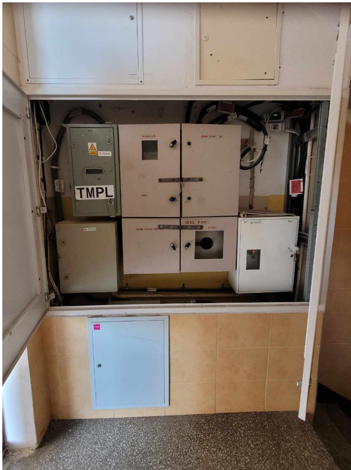
Rysunek 25 - - rozdzielnia do wymiany na nową i przeniesienia
