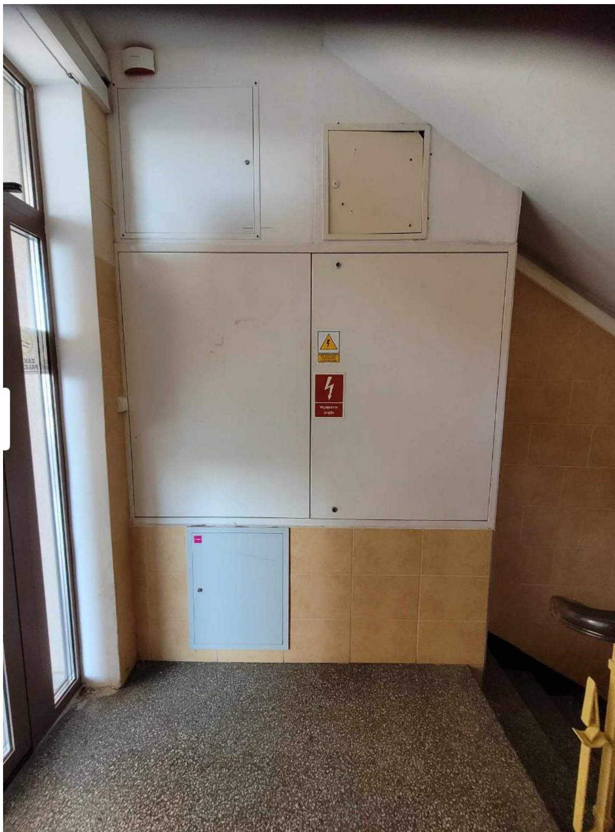
Rysunek 24 - rozdzielnia do wymiany na nową i przeniesienia
