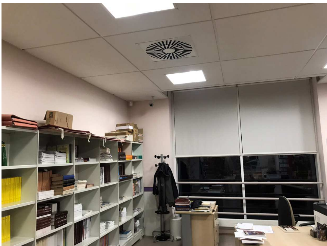
Dok. fot. nr 4 – sufit podwieszany w bibliotece na piętrze, wnęki nad oknem pozostają bez zmian
