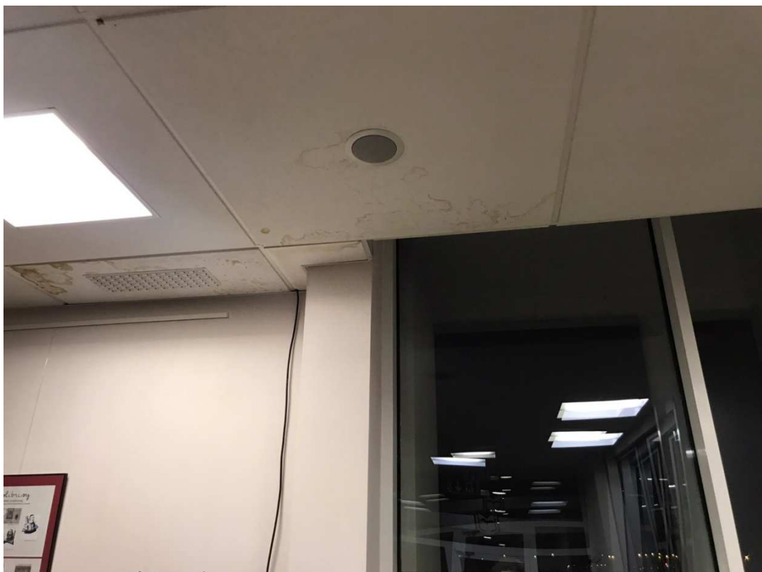
Dok. fot. nr 8 – zabrudzone kasetony do wymiany wykorzystać z poziomu parteru
