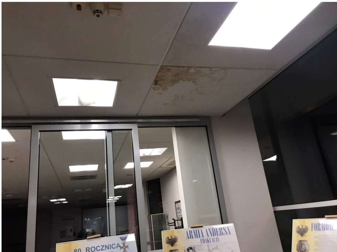
Dok. fot. nr 7 – zabrudzone kasetony do wymiany wykorzystać z poziomu parteru
