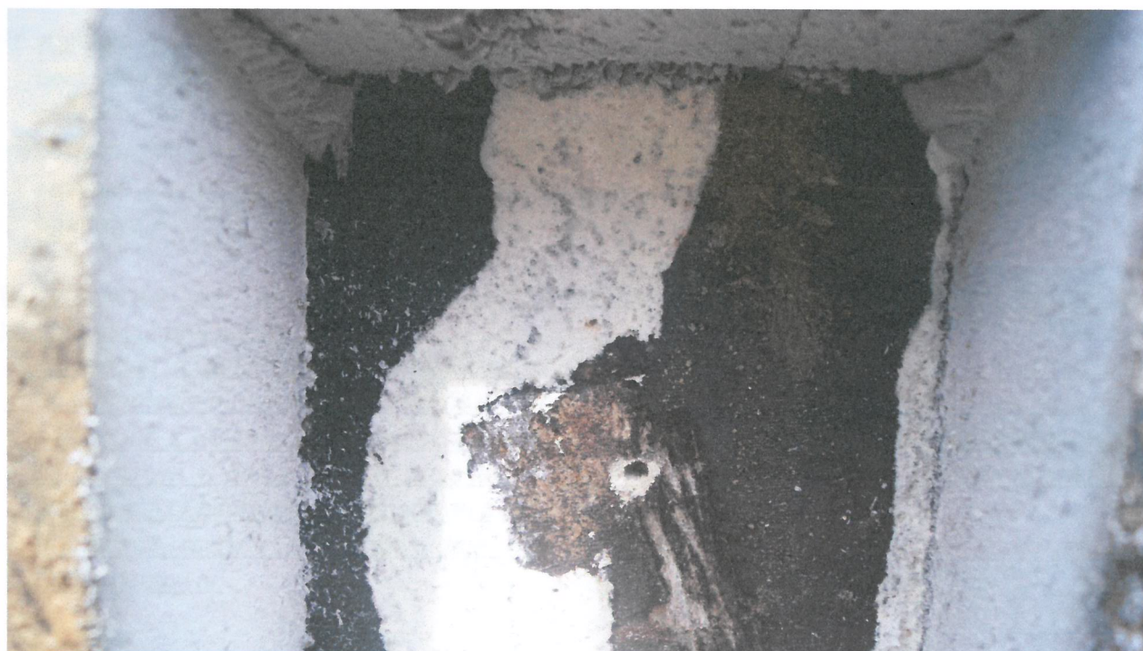
Odkrycie uszkodzonego stanu fundamentu Podczas prac remontowych wewnątrz budynku
