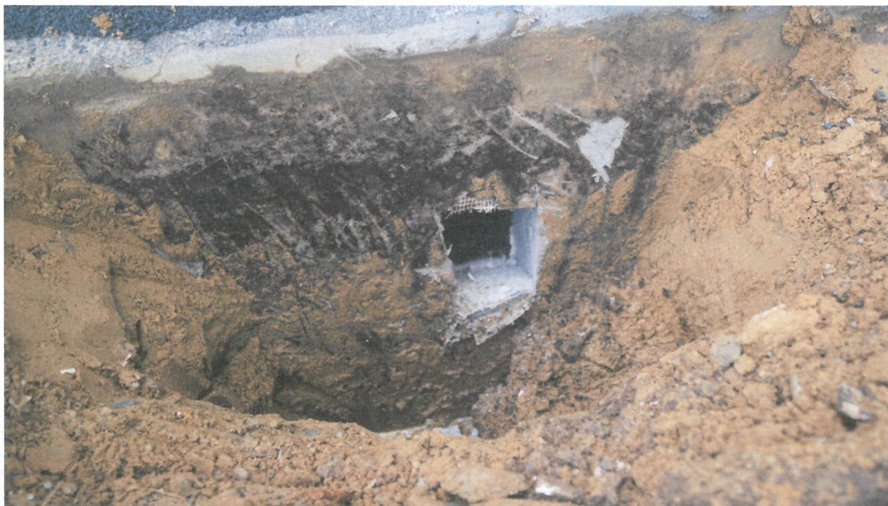
Odkrycie uszkodzonego stanu fundamentu Podczas prac remontowych wewnątrz budynku
