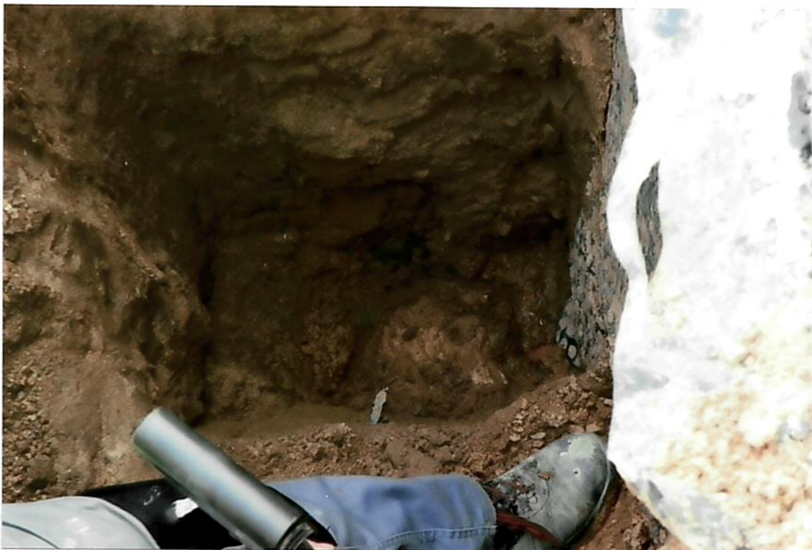
Odkrywka drenażu od strony północno - wschodniej. Lokalizacja studzienki najbliższa rowów melioracyjnych.
