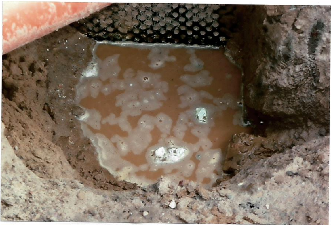
Odkrywka drenażu od strony północno - zachodniej. Woda gruntowa gromadząca się nad drenażem.
