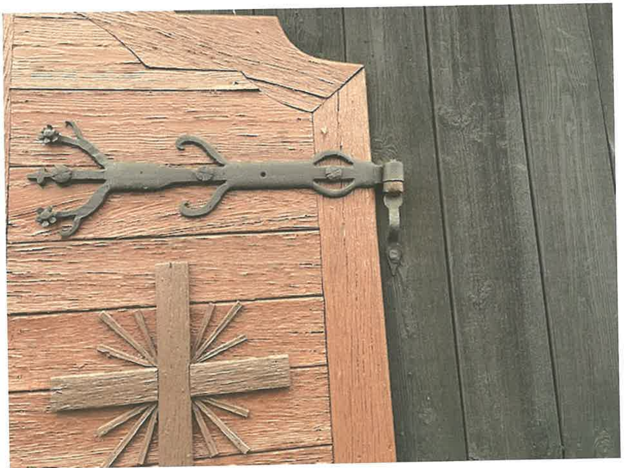
DRZWI GŁÓWNE PRZED KONSERWACJĄ I RESTAURACJĄ, STRONA WEWNĘTRZNA:
