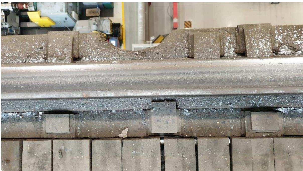
Fot.20. Uszkodzenie pasa górnego belki podsuwnicowej na torze zachodnim. Wycięty fragment pasa i blachy nakładkowej.
