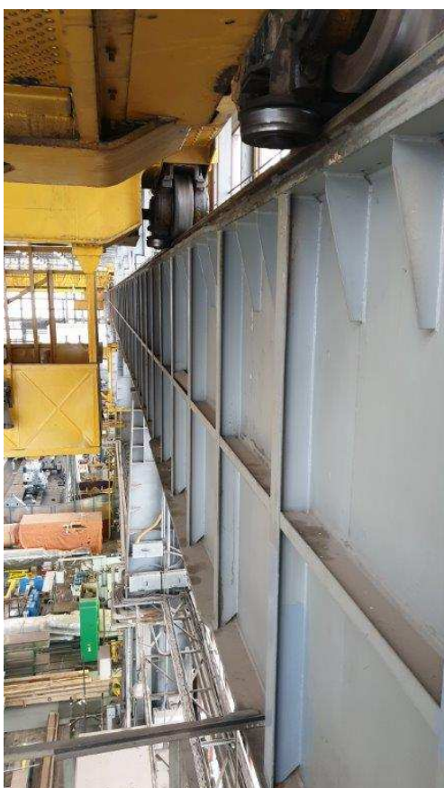
Fot.24. Belka podsuwnicowe na hali B1 nawa 10. Widoczna konstrukcja belki.
