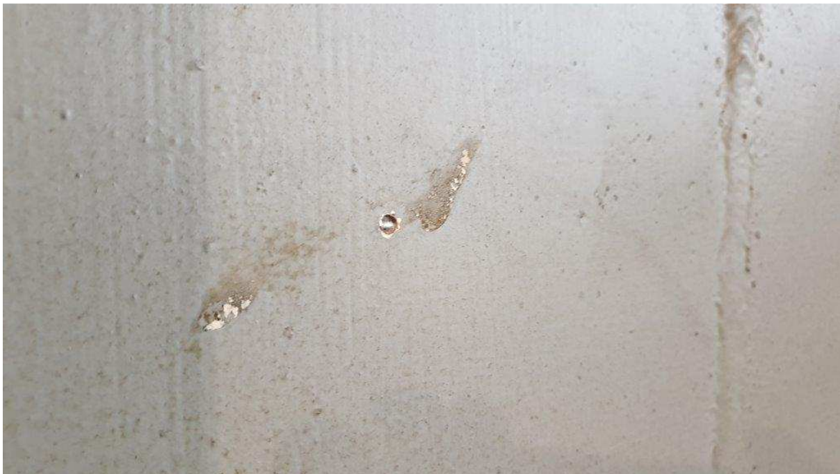
Fot.31. Inwentaryzacja grubości średnika belki podsuwnicowej. Przewiert kontrolny.
