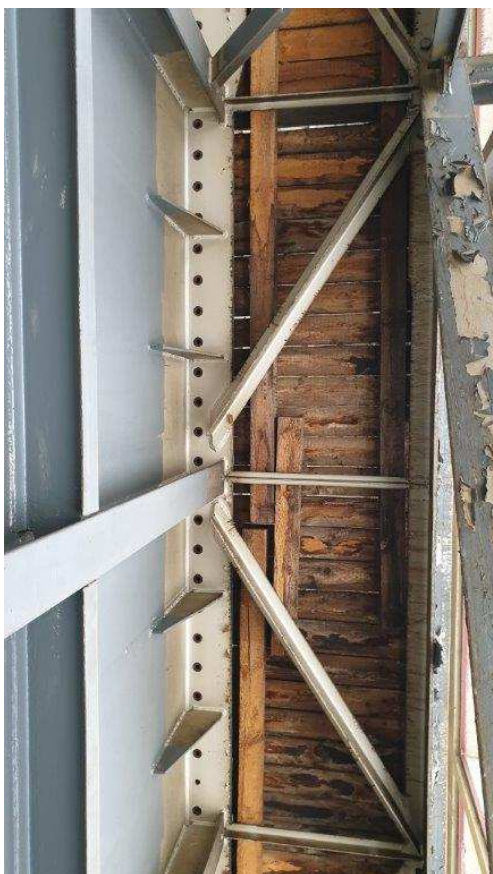
Fot.27. Jak na fot ... inne ujęcie. W pasie górnym belki podsuwnicowej widoczne otwory po nitach.
