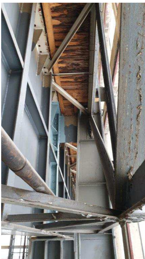
Fot.29. Połączenie górnej części belki podsuwnicowej ze słupem. Widoczne połączenie skrucane.
