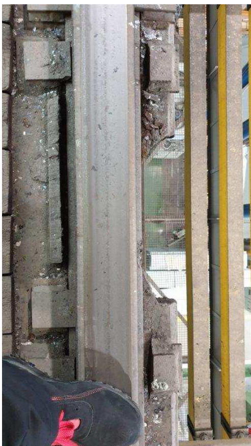
Fot.14. Uszkodzenia pasa górnego belki podsuwnicowej oraz blachy nakładkowej na torze zachodnim.
