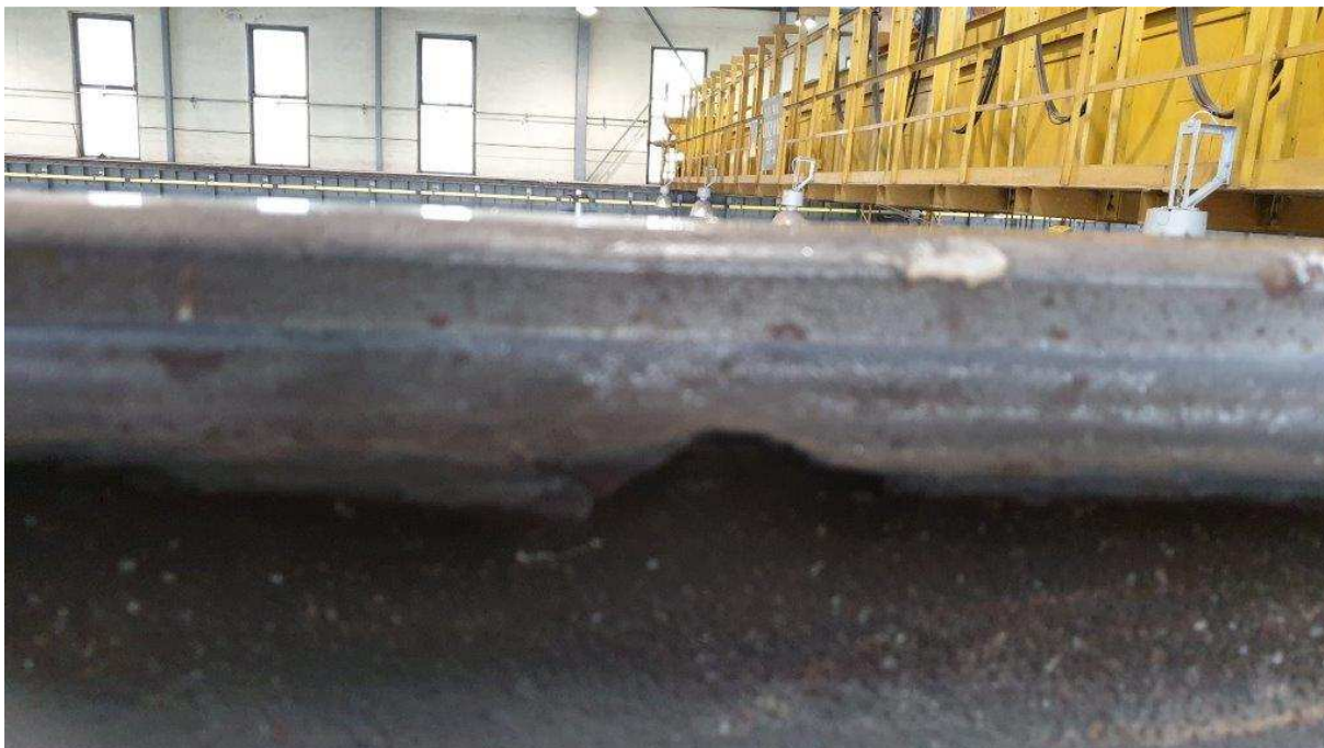
Fot.16. Uszkodzenie szyny.
