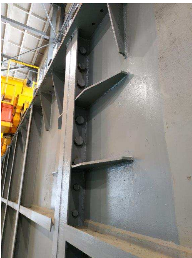
Fot.32. Połączenie doczołowe belki podsuwnicowej nad podporą. Widoczne efekty robót wzmacniających połączenie w związku z dopuszczeniem do pracy na torze trzeciej suwnicy o udźwigu Q=100t/5t w pełnym zbliżeniu. Widoczne 6 nowych śrub oraz żebra wzmacniające.
