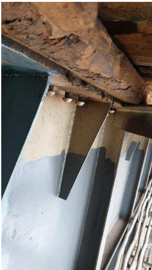
Fot.25. Widok belki podsuwnicowej pod pomostem. Widoczne nity stalowe – pozostałość po powrotnym mocowaniu szyny do pasa górnego za pomocą nitów.
