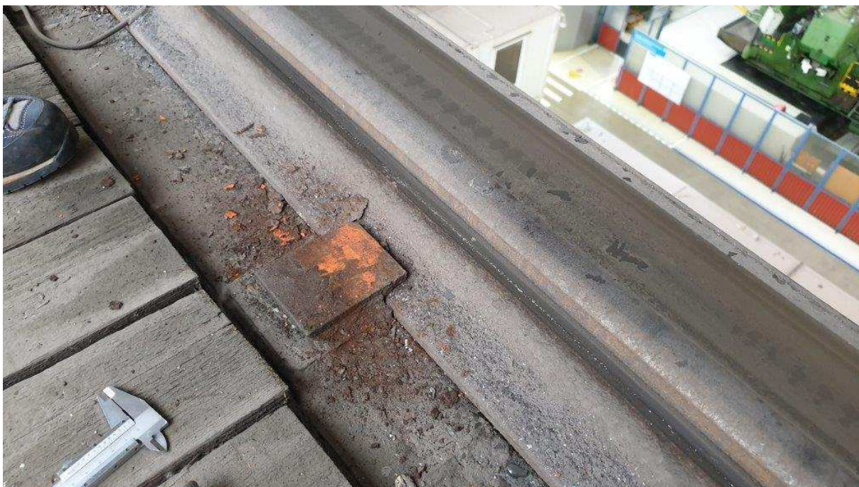
Fot.10. Istniejące obecnie sztywne połączenie szyny z podtorzem. Widoczne oznaki rdzy.
