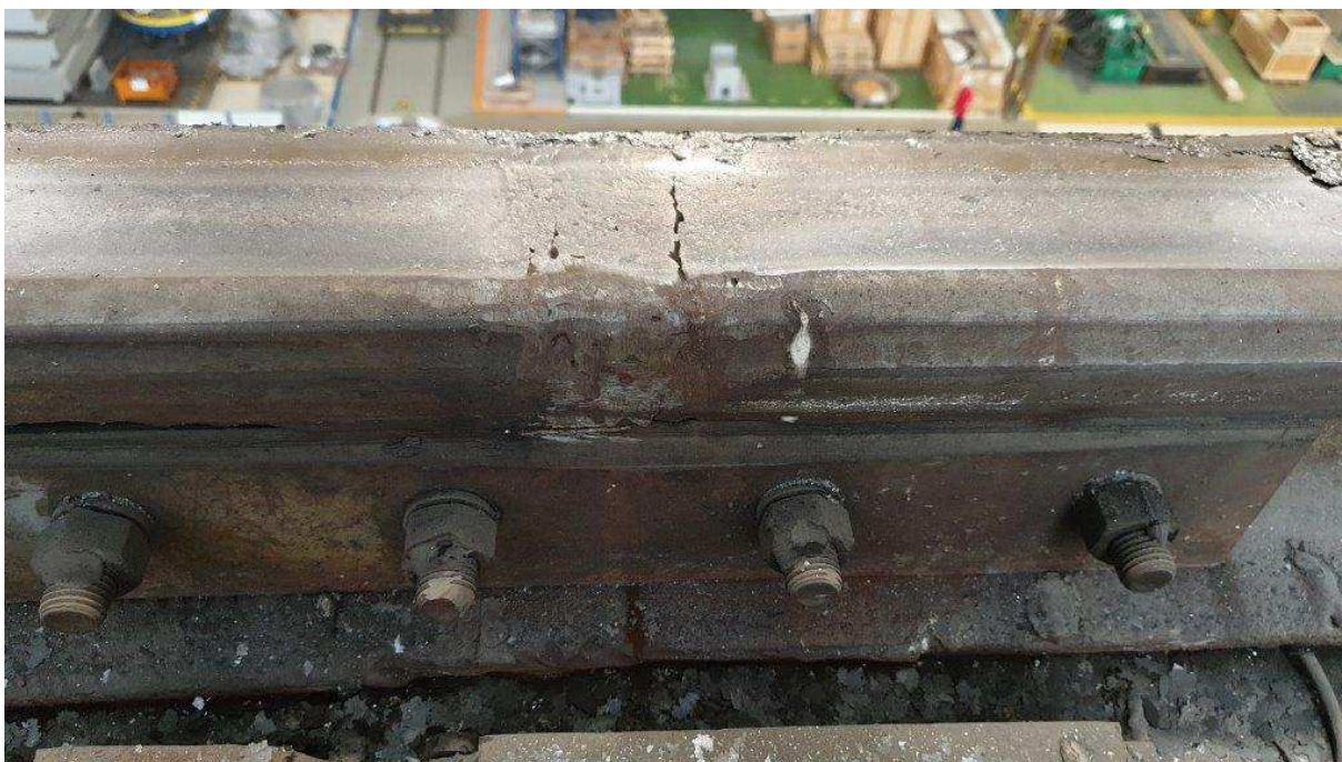
Fot.13. Jak na fot. 12, inne miejsce. Widoczna zaspawana szpara między szynową.
