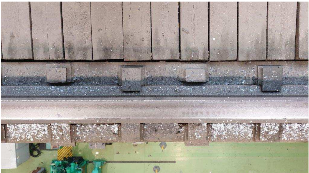
Fot.18. Istniejąca szyna SP 120. Widoczny sposób mocowania oraz ślady po rektyfikacji (obcięte kłemy) z roku 2009.
