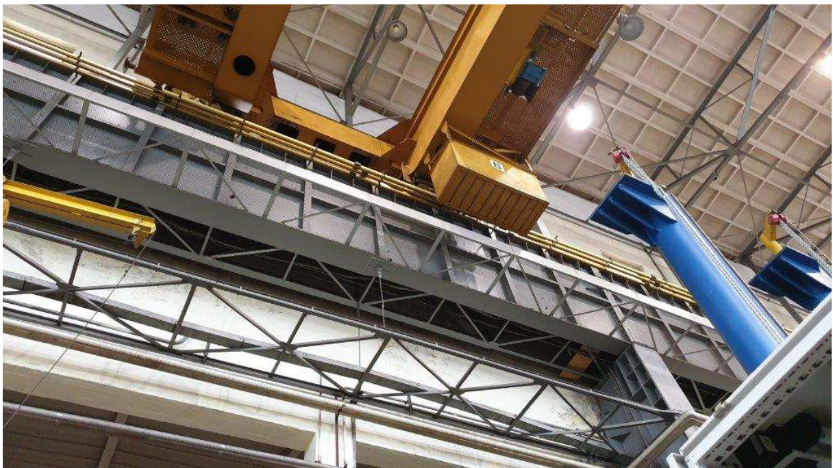
Fot.4. Belka podsuwnicowa toru zachodniego.
