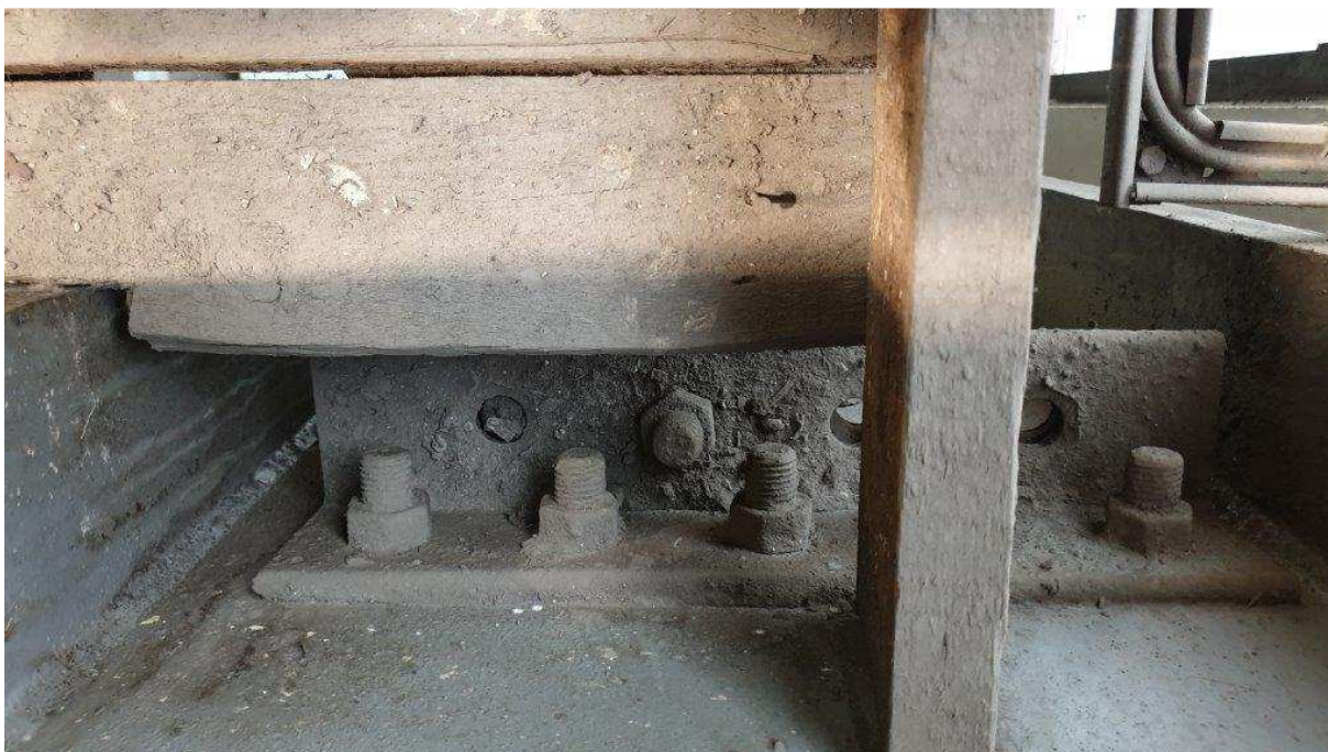
Fot.30. Jedno z połączeń tężnika hamownego ze słupem. Widoczny częściowy brak łączników śrubowych.
