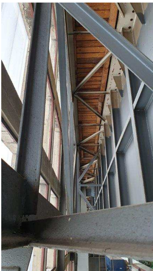
Fot.28. Tężnik hamowny belki podsuwnicowej – inne miejsce
