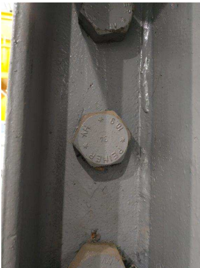
Fot.33. Zbliżenie na nowe śruby w połączeniu doczołowym. Śruby typu HV klasy 10.9.
