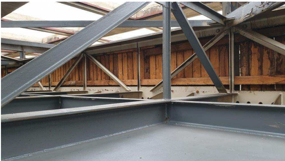
Fot.26. Widok tężnika hamownego belki podsuwnicowej od dołu. Widoczny sposób połączenie kratownicy tężnika z pasem górnym belki poprzez spawanie.
