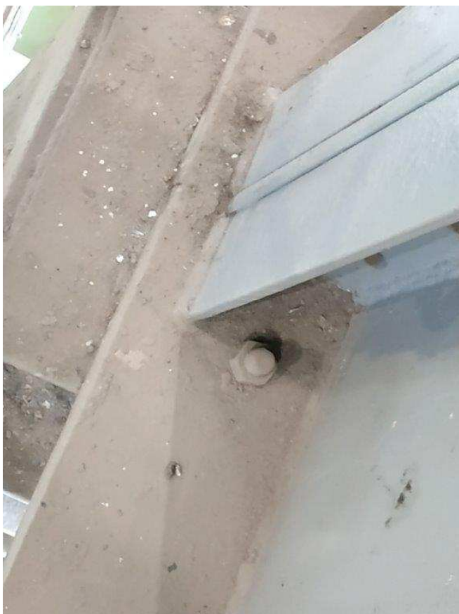
Fot.35. Oparcie belki podsuwnicowej na podporze.
