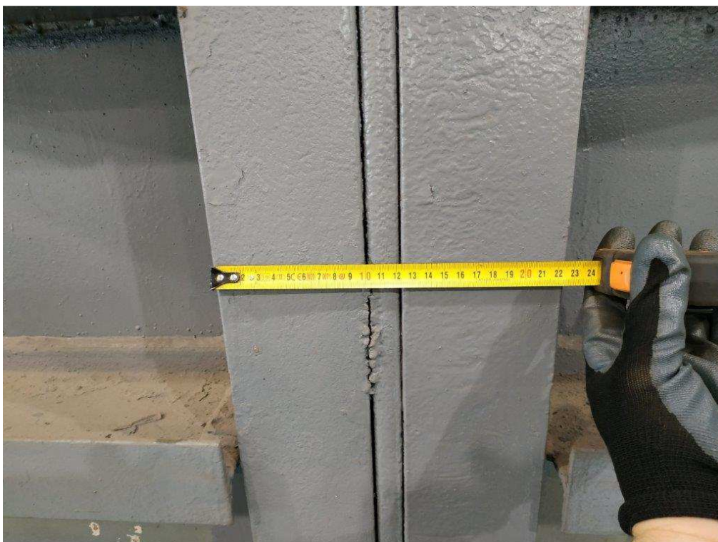
Fot.34. Styk czołownic belek podsuwnicowych. Widoczna blach przekładowa.
