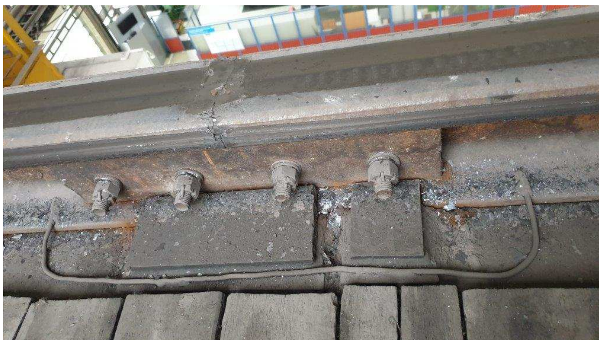
Fot.12. Istniejące łukowe połączenie szyn na torze.
