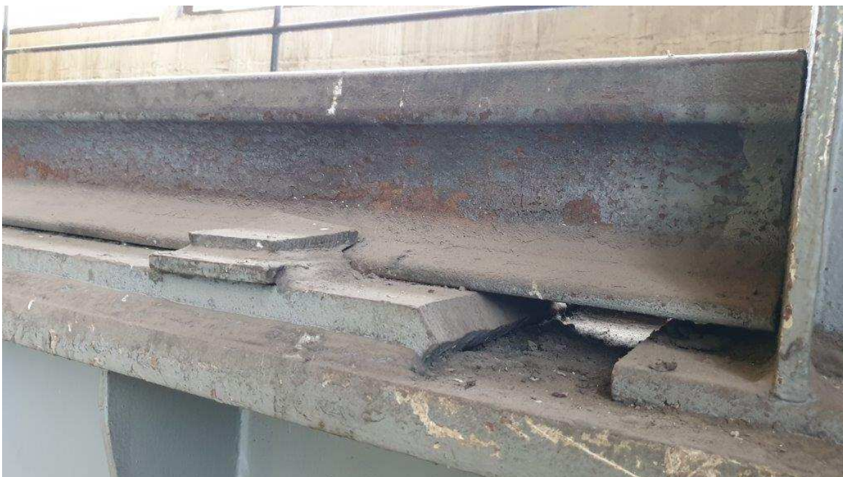
Fot.23. Początek szyny na torze wschodnim. Widoczny sposób mocowania szyny do blachy nakładkowej spawanej do pasa górnego belki podsuwnicowej.
