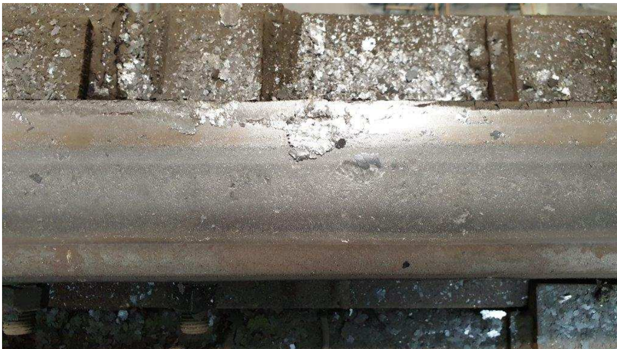
Fot.19. Istniejąca szyna SP 120. Widoczne stalowe opiłki spotykane wzdłuż całego toru.
