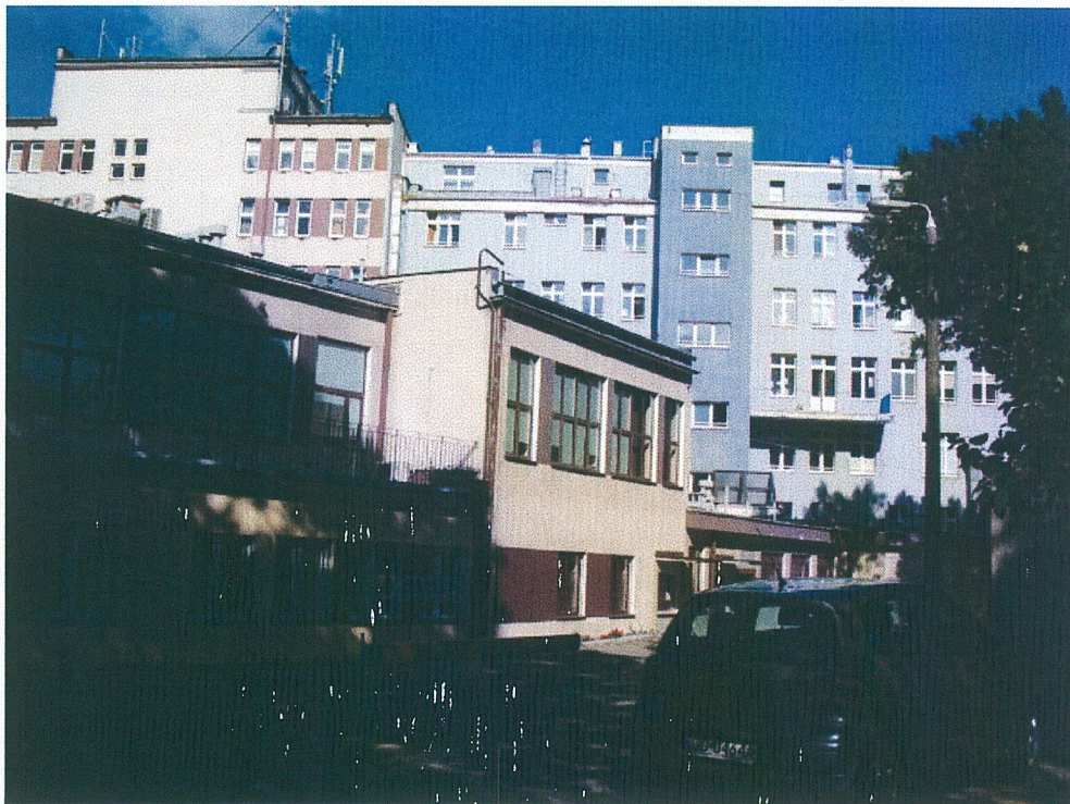
Fragmenty widoku budynku głównego od strony zaplecza –na pierwszym planie część niska (pawilon z częścią przychodni i rehabilitacji) oraz poniżej część niska z apteką
