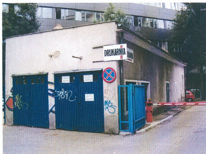
Budynek garaży z trafostacją
