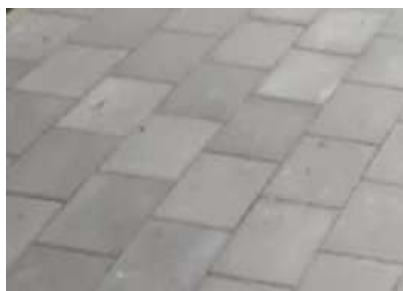
Fot.5. Układ ciosowy płytek chodnikowych
