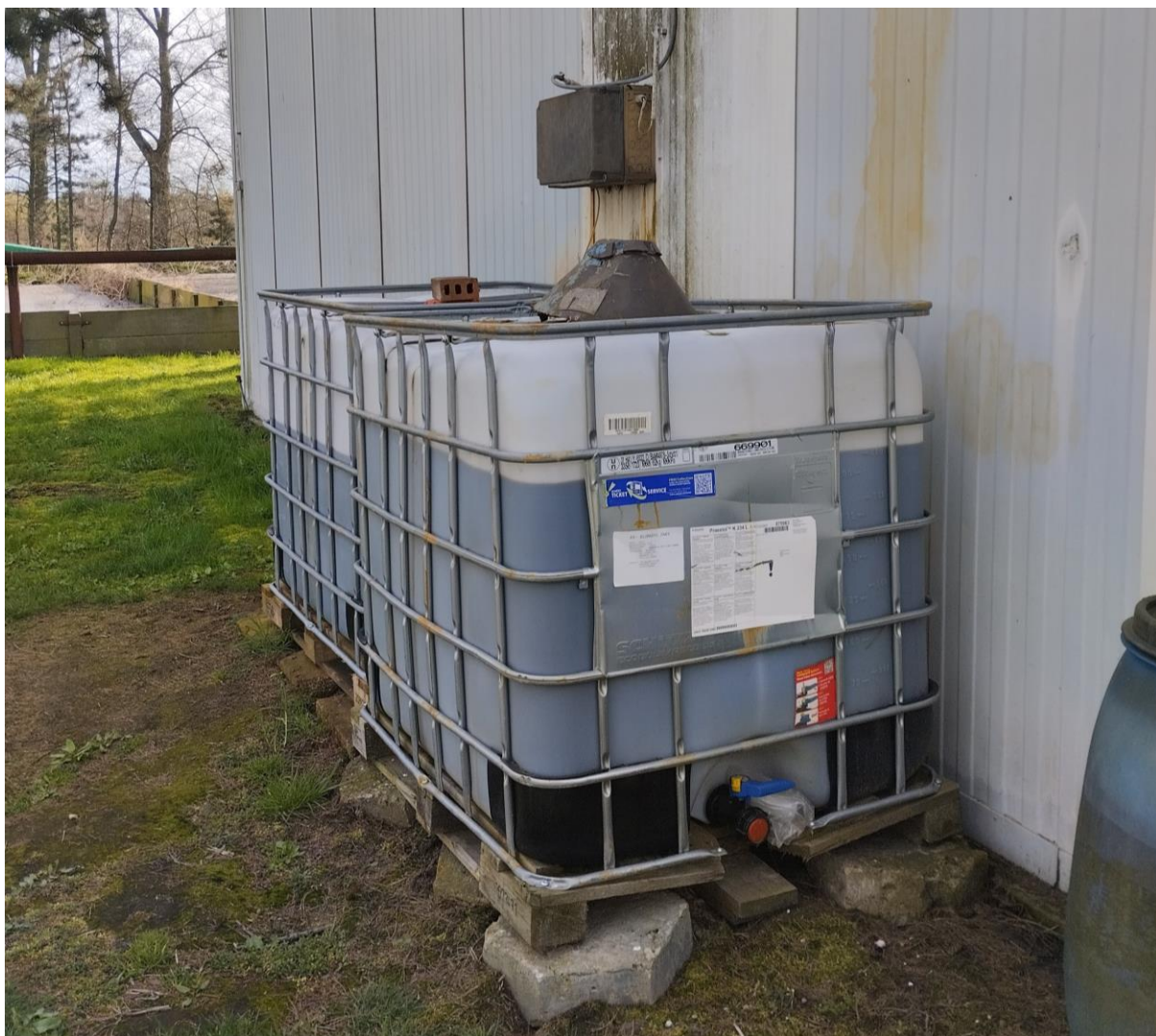
Rysunek 7 Stacja dawkowania koagulantu PIX 113
