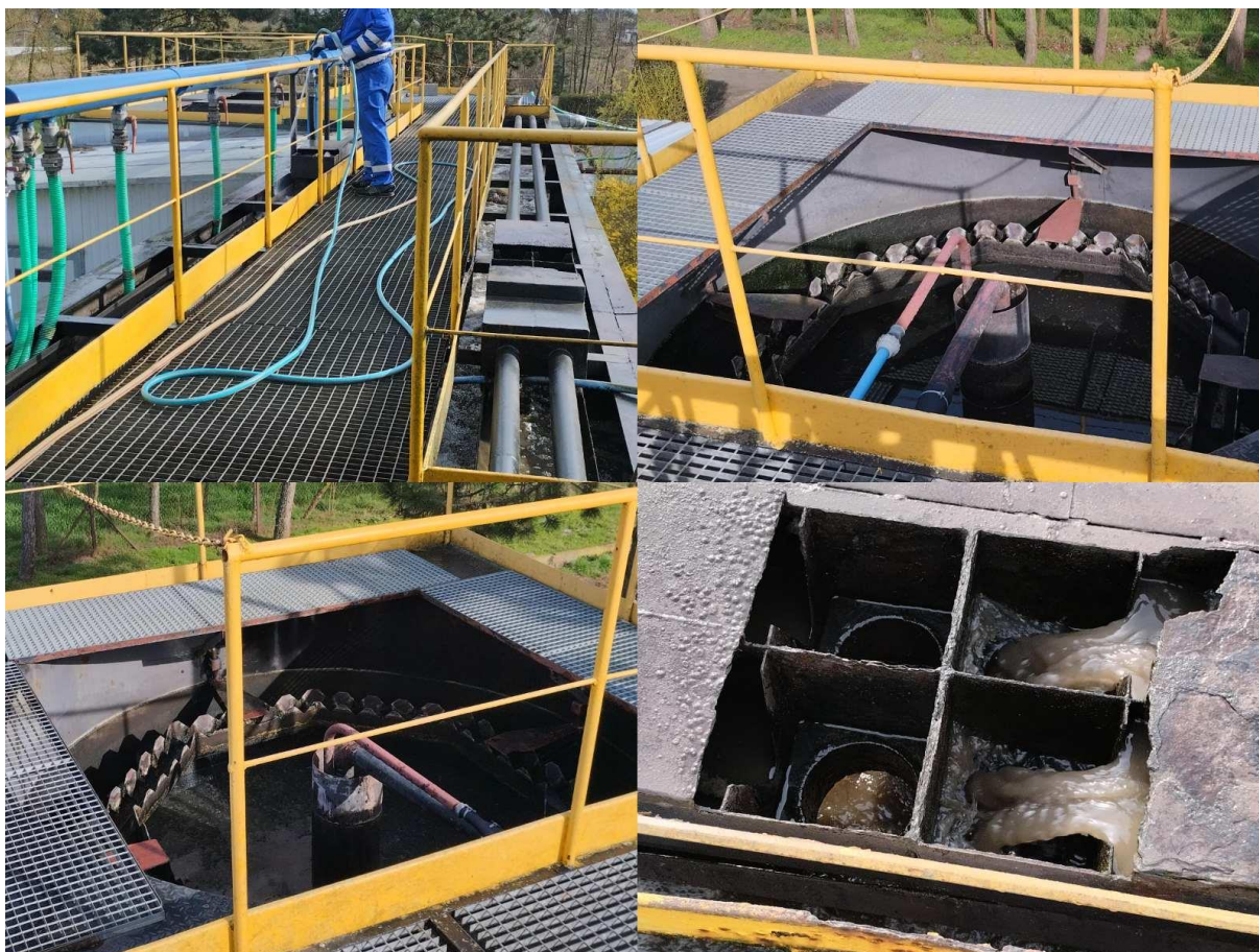
Rysunek 5 Reaktor typu Bioblok PS200
