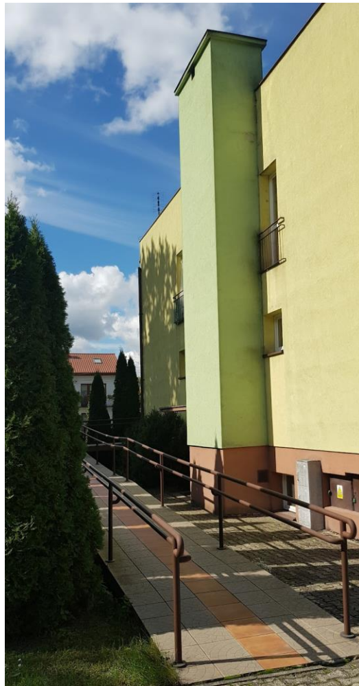
Fot. nr 4. Widok elewacji południowej
