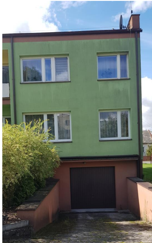
Fot. nr 2. Widok części elewacji wschodniej – wjazd do garażu
