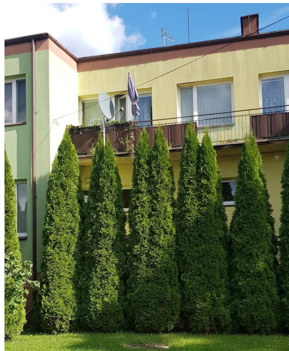
Fot. nr 5. Widok fragmentu elewacji zachodniej
