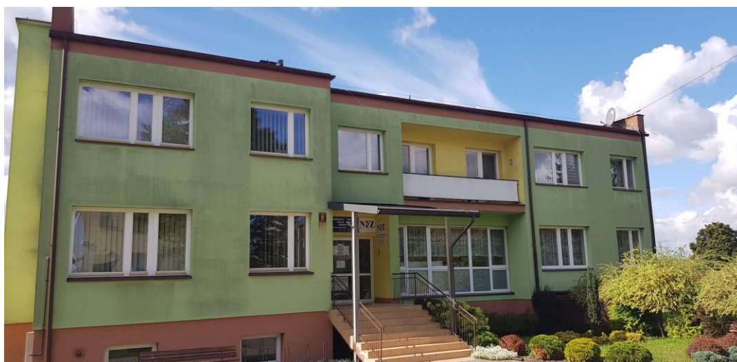
Fot. nr 1. Widok elewacji wschodniej – wejście główne do budynku
