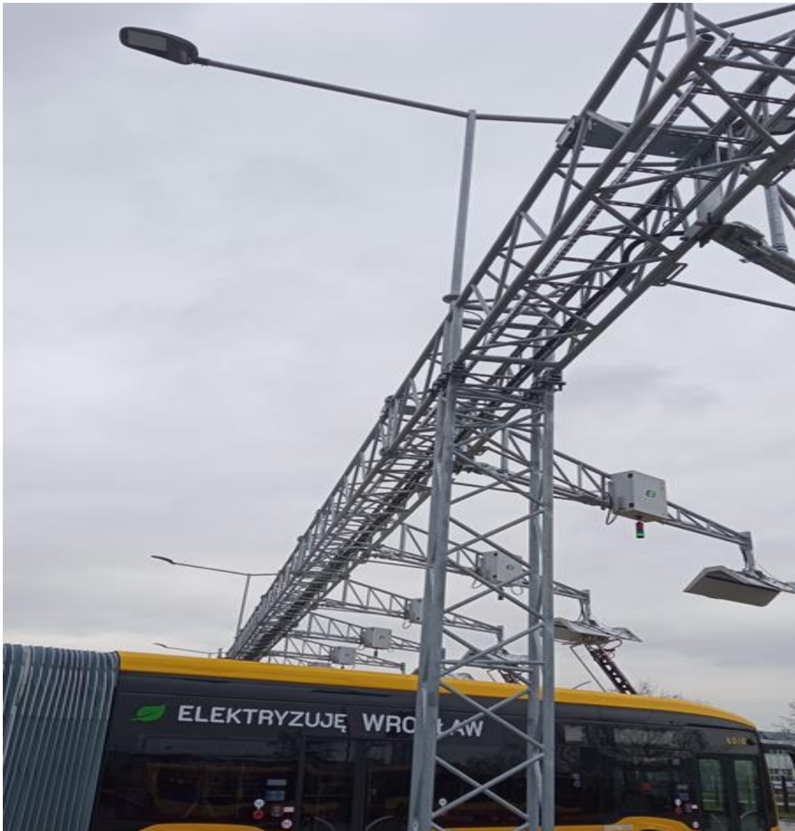
Widok konstrukcji obecnej bramownicy wraz z podporami-filarami.
