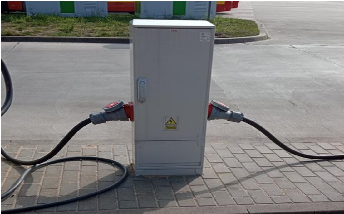
RYСУNEK : ZK 120kW z 2 gniazdami 3F(trójfazowymi) – 2 ZASILANIA 60KW
